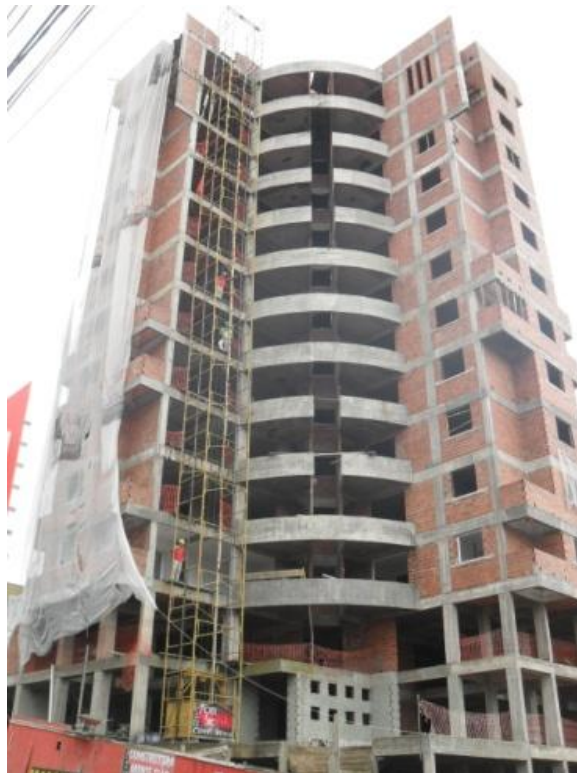
Figura 11- Edifício em Construção Fonte: Autores, 2011.
