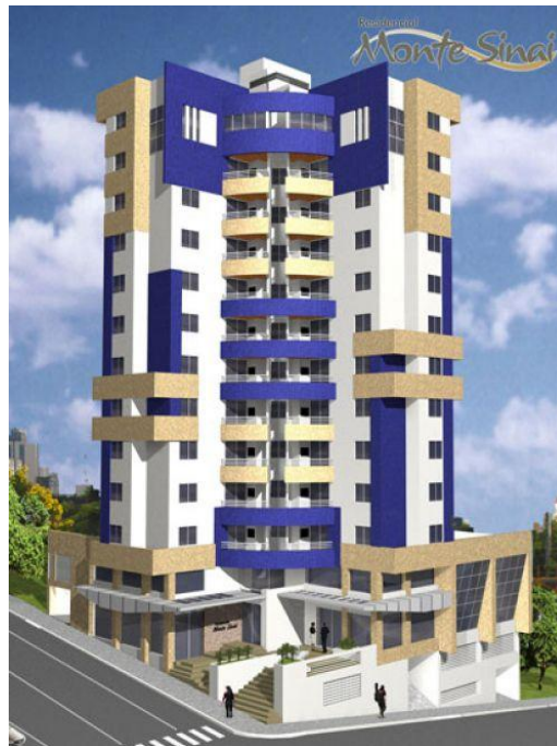
Figura 10 - Edifício em Estudo Fonte: Construtora Monte Sião, 2011.
