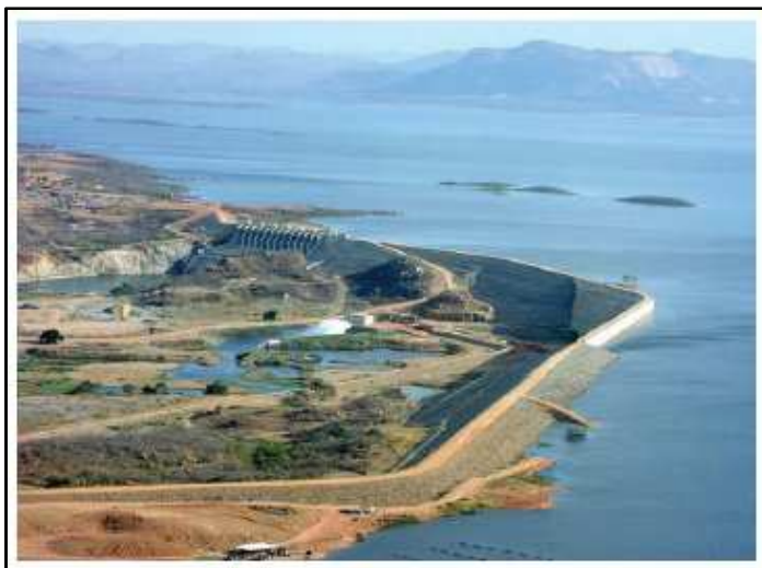
Figura 2 - Barragem de Cedros, uma das duas mais antigas grandes barragens do Brasil. Fonte: CBDB (2011).
