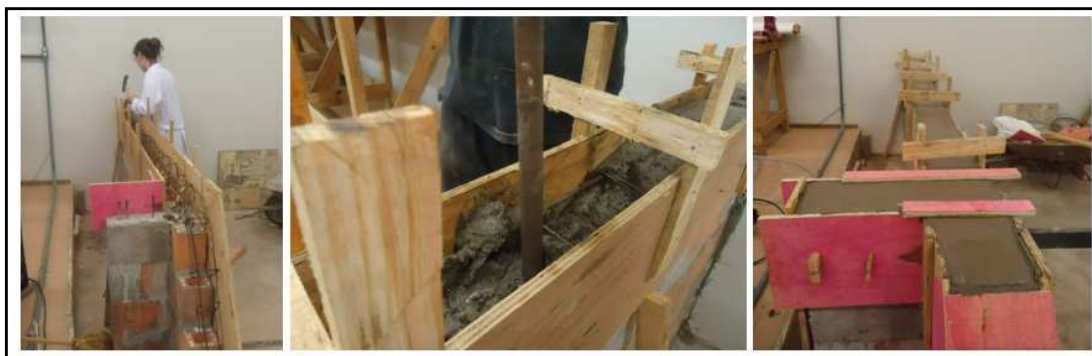
Figura 33 - Execução de viga sobre parede. Fonte: As autoras (2013).
