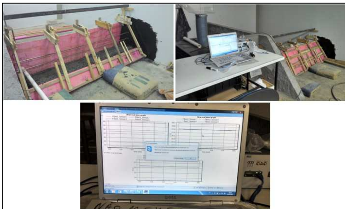
Figura 37 - Fibras óticas instaladas e monitoramento da temperatura no interior da barragem através de software.
