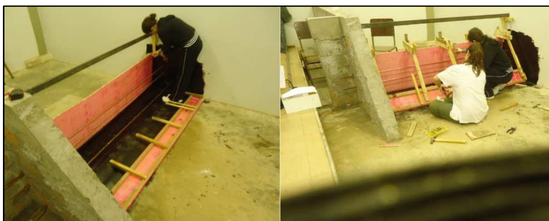
Figura 34 - Montagem de formas. Fonte: As autoras (2013).
