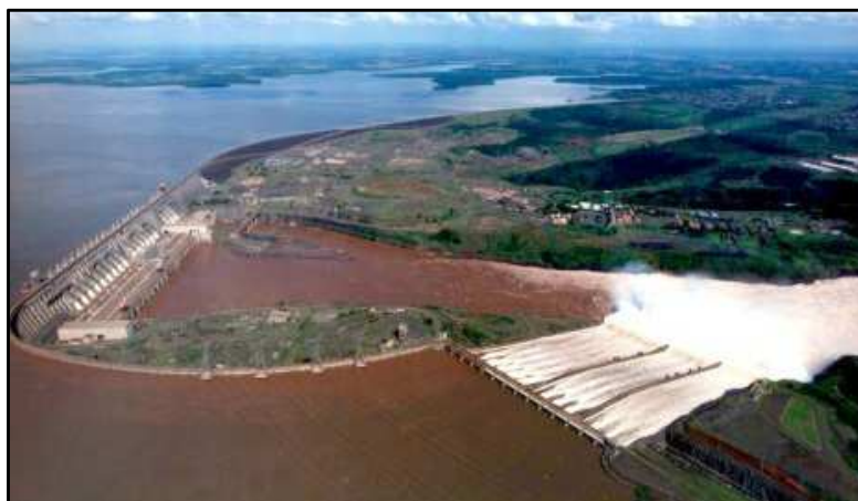
Figura 17 - Barragem de Itaipu. Fonte: ITAIPU (2013).
