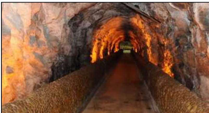
Figura 4 - Túnel na obra de São Francisco. Fonte: Prefeitura de Paulo Afonso (2013).
