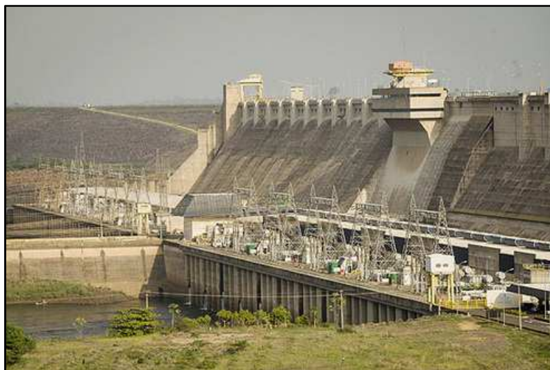
Figura 7 - Barragem da Usina Elétrica de Tucuruí. Fonte: Folha de São Paulo (2013).
