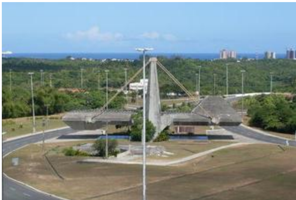
Figura 7 - Edifício "Balança" do Centro Administrativo da Bahia
