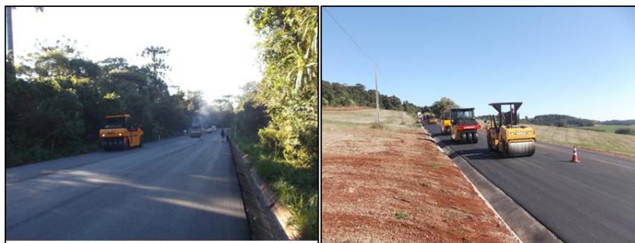
Figura 46: Execução da camada anti-reflexão Fonte: Empresa X, 2013.
