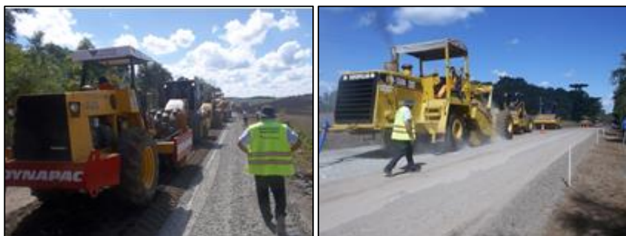
Figura 43: Reciclagem do pavimento
