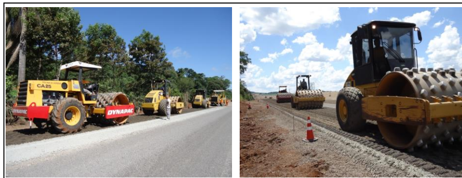
Figura 44: Compactação Fonte: Empresa X, 2013.
