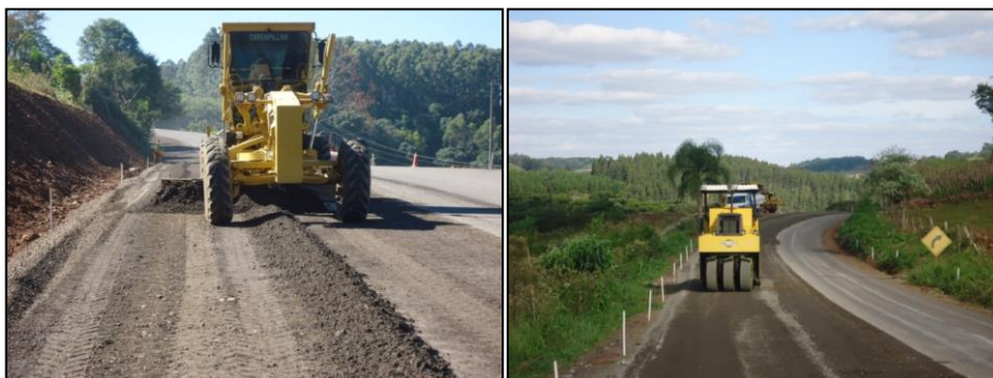
Figura 45: Acabamento com motoniveladora e compactação final da base Fonte: Empresa X, 2013.
