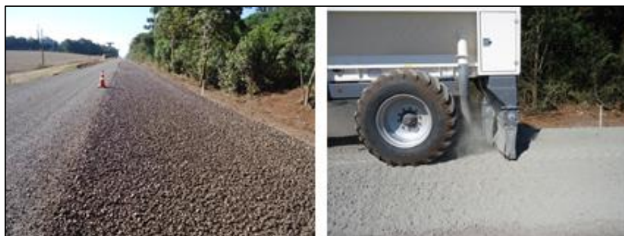
a) Espalhamento do agregado
