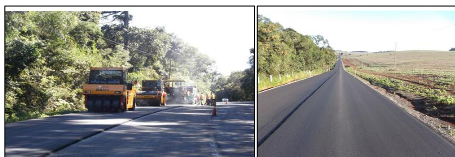
Figura 47: Execução da 1ª camada de CBUQ com borracha Fonte: Empresa X, 2013.
