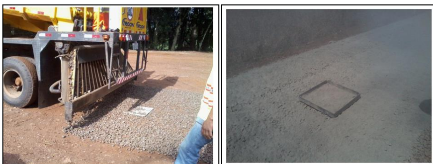
Figura 38: Calibração da taxa de agregado e cimento
