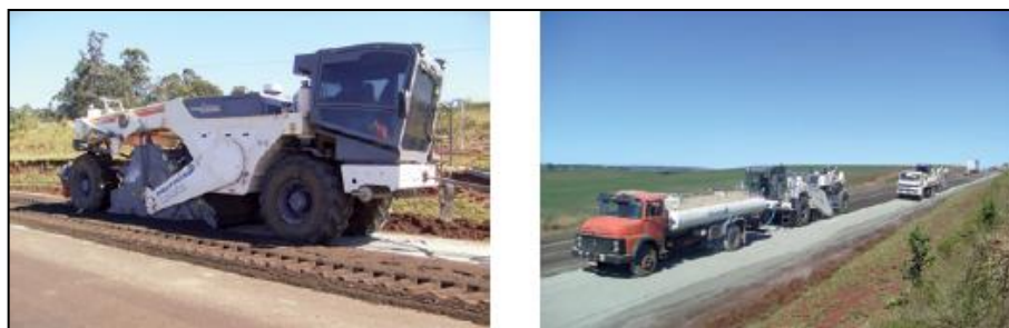
Figura 25: A esquerda reciclagem a frio " in situ " e a direita "trem de reciclagem" Fonte: Costa e Pinto, 2011.
