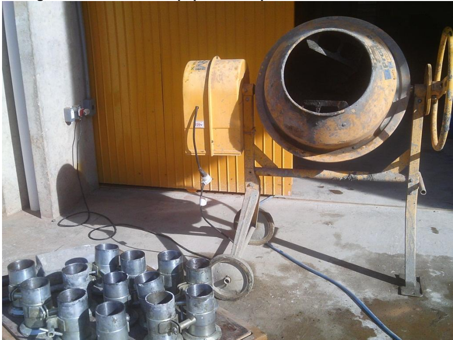
Figura 5 – Materiais e equipamentos para a mistura do concreto
