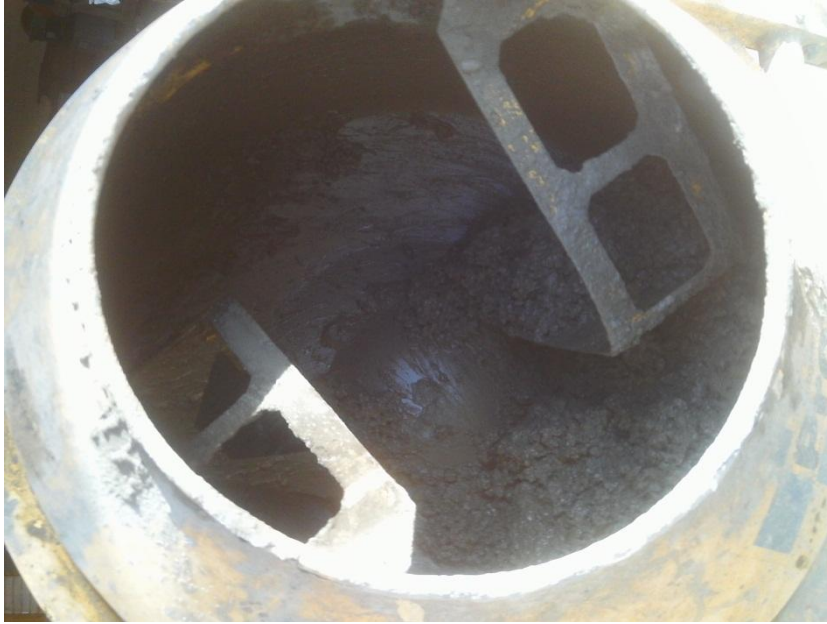
Figura 6 – Concreto sendo misturado na betoneira
