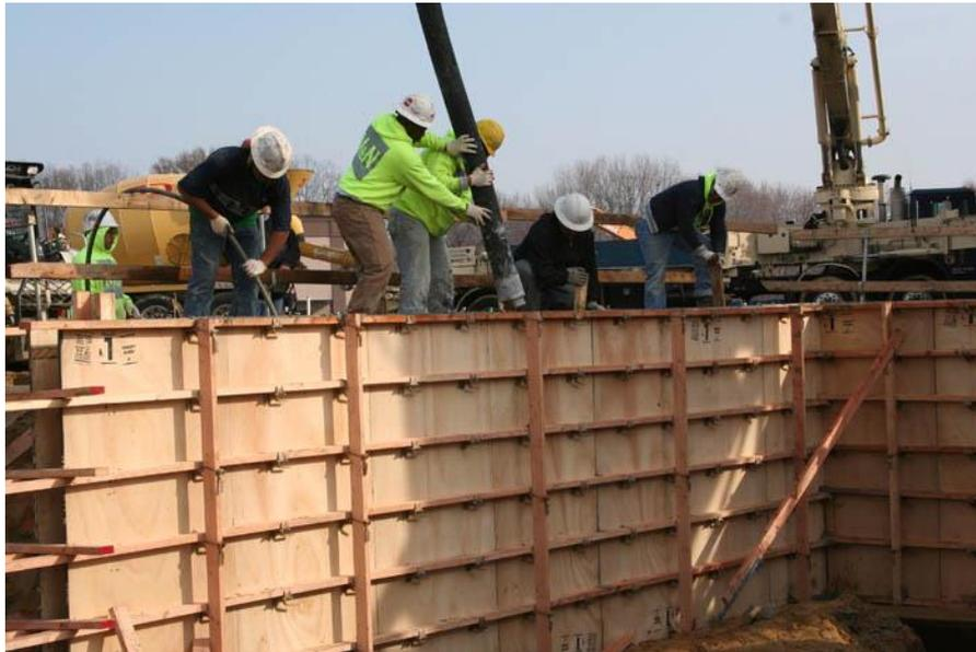
**FIGURA 7 - Conjunto de fôrmas de madeira e lançamento do concreto**
