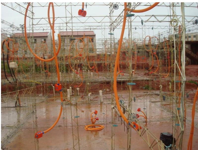
**FIGURA 9 – Armação com treliças e instalações de eletrodutos, para paredes de concreto**
