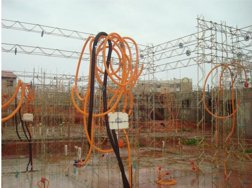
**FIGURA 10 – Eletrodutos, caixas elétricas e espaçadores**
