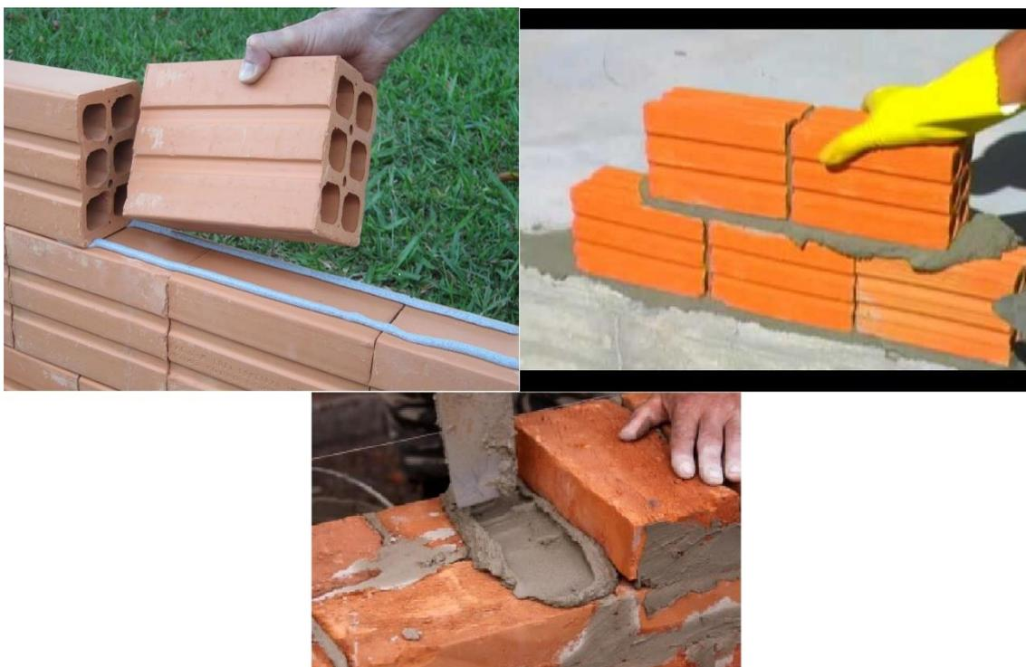
**FIGURA 1 - Exemplos de aplicação da argamassa de assentamento, em blocos cerâmicos**
