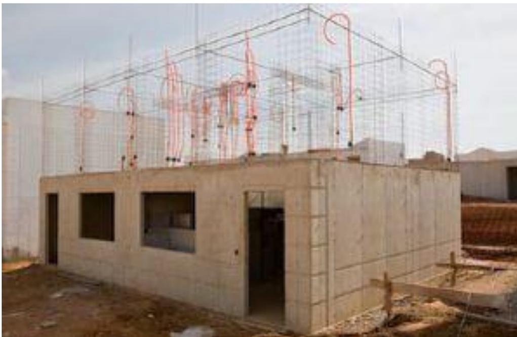
**FIGURA 5 – Edificação confeccionada a partir do método de parede de concreto moldada no local, a armadura posicionada e os elementos elétricos embutidos**
