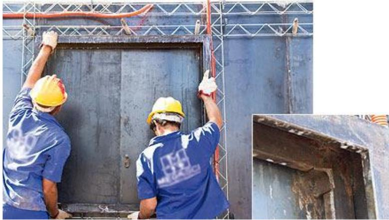
**FIGURA 11 – Execução do gabarito de uma janela, em parede de concreto moldada no local**
