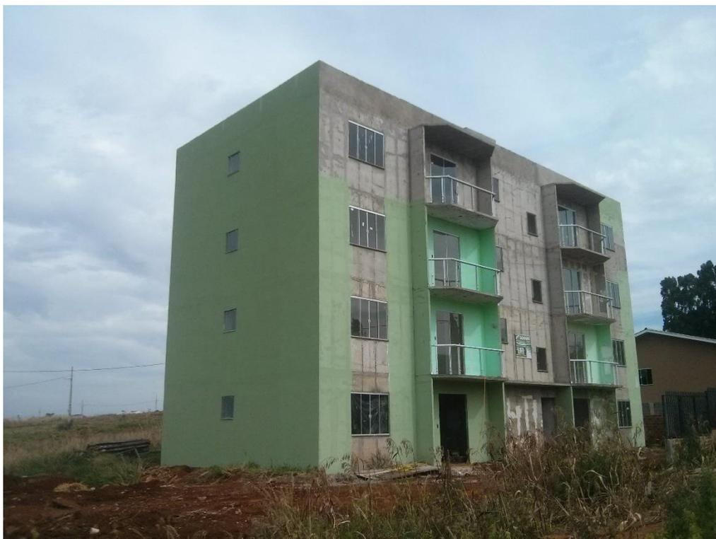
**Figura 18 - Fachada edifício executado em Parede de concreto moldada no local**
