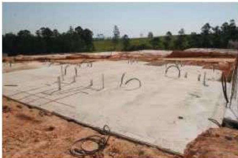
**FIGURA 8 - Radier de uma obra executada em parede de concreto moldada no local**
