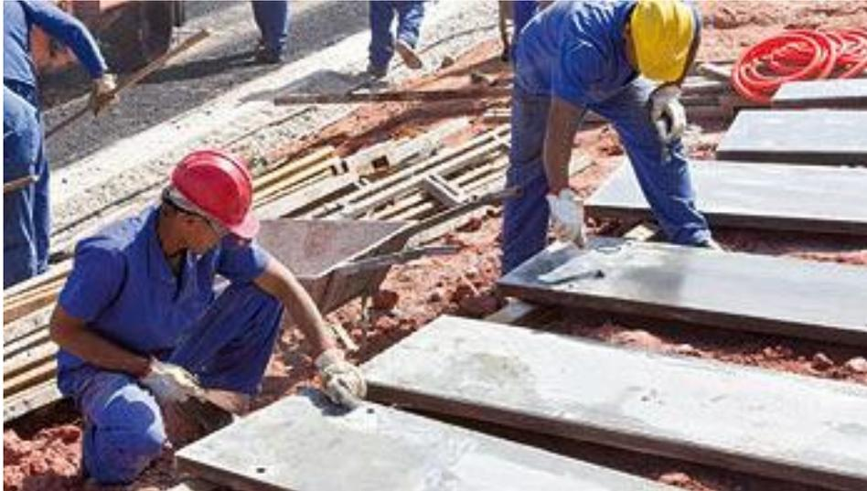
**FIGURA 13 – Limpeza das chapas das fôrmas**
