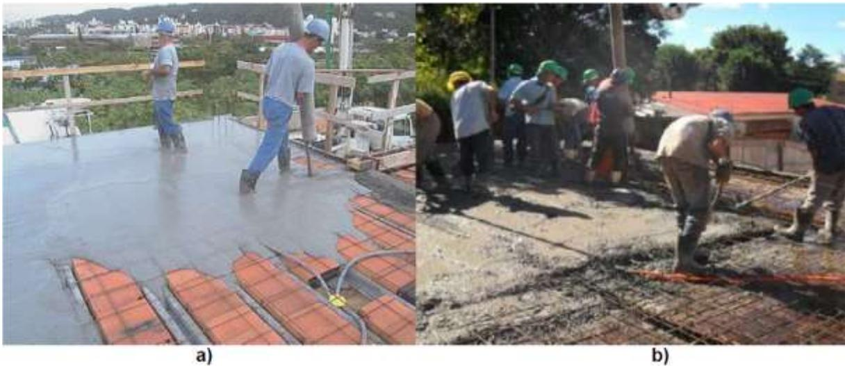
**Figura 5 – a) Concretagem com CAA b) Concretagem em CCV**
