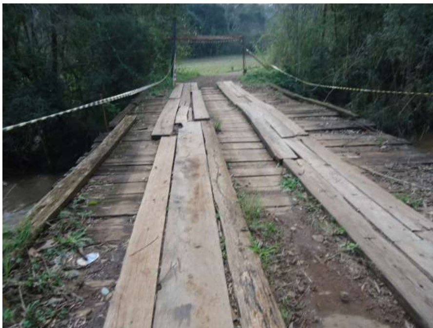
Figura 45 – Inspeção Visual da Ponte P003
