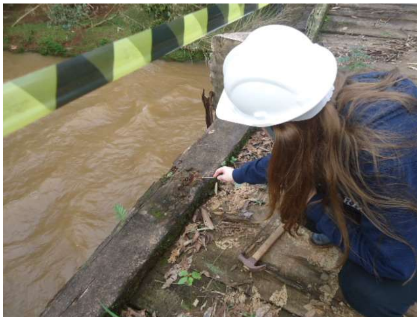
Figura 47 – Técnica de sondagem superficial da Ponte P003
