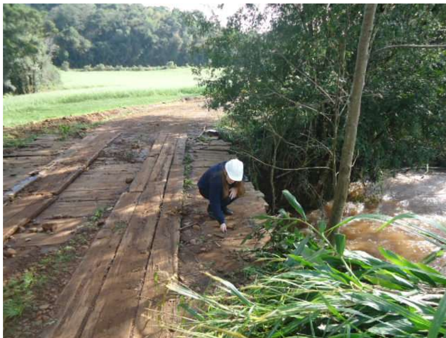
Figura 35 – Técnica de sondagem superficial da Ponte P001
