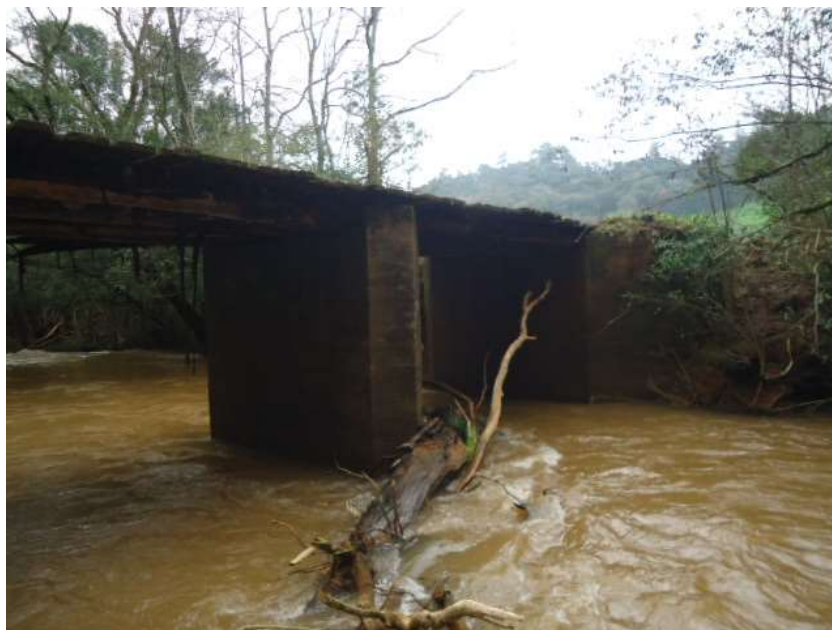
Figura 5 – Ponte em madeira na região do Extremo Oeste Catarinense
