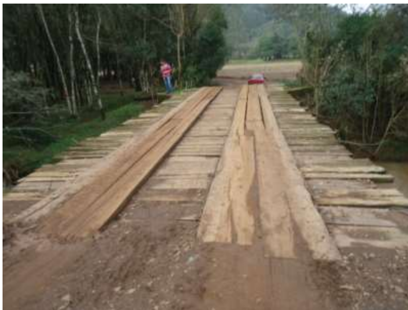
Figura 57 – Inspeção Visual da Ponte P005
