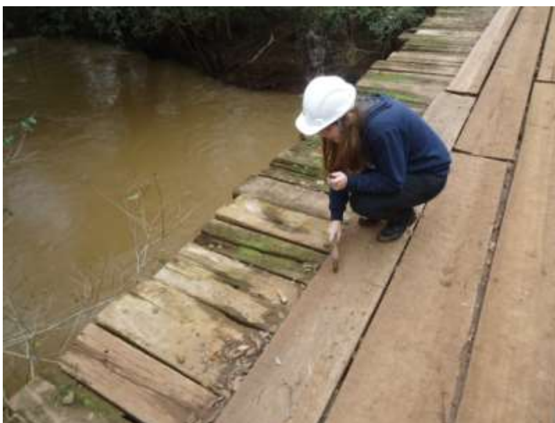
Figura 58 – Técnica de percussão: interpretação sonora com martelo da Ponte P005
