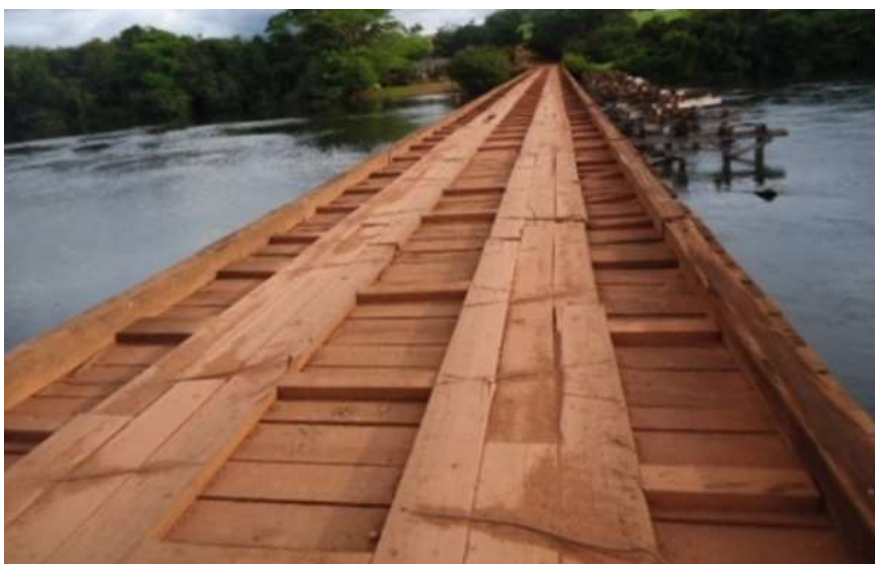
Figura 2 - Ponte em madeira localizada no estado do Mato Grosso
