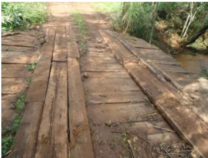
Figura 33 – Inspeção Visual da Ponte P001
