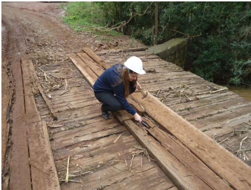
Figura 53 – Técnica de sondagem superficial da Ponte P004
