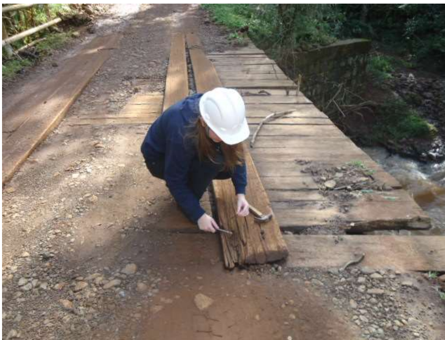
Figura 41 – Técnica de sondagem superficial da Ponte P001
