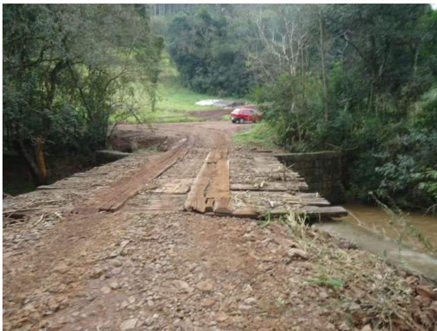
Figura 51 – Inspeção Visual da Ponte P004
