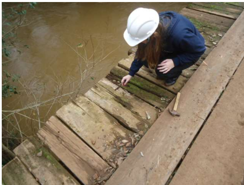
Figura 59 – Técnica de sondagem superficial da Ponte P005
