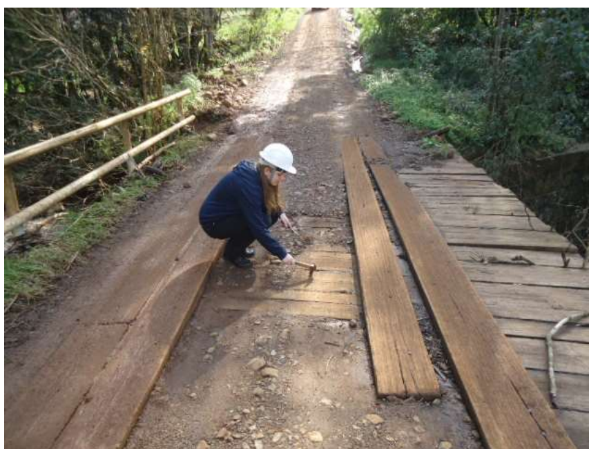
Figura 40 – Técnica de percussão: interpretação sonora com martelo da Ponte P002
