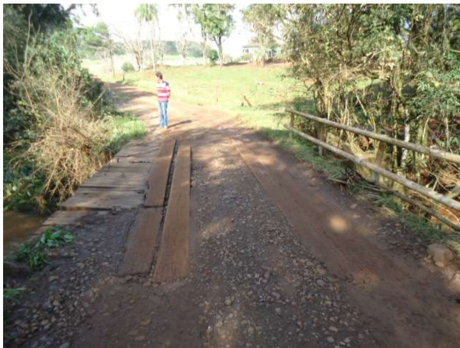
Figura 39 – Inspeção Visual da Ponte P002
