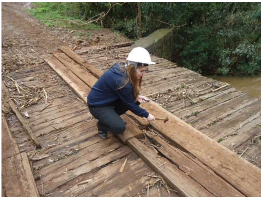
Figura 52– Técnica de percussão: interpretação sonora com martelo da Ponte P004
