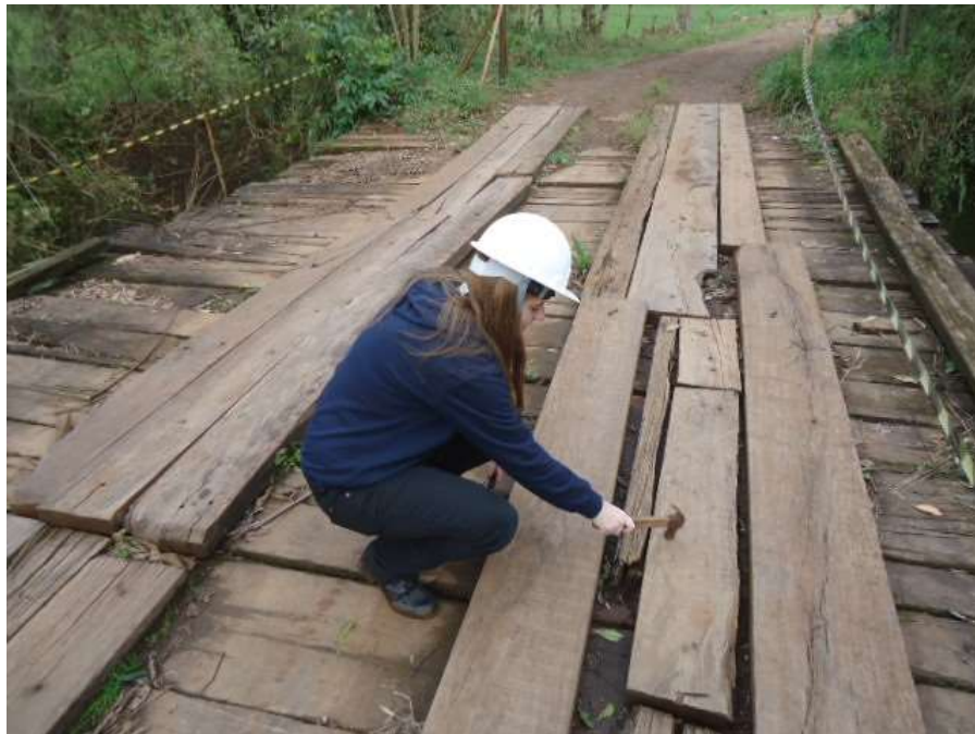
Figura 46 – Técnica de percussão: interpretação sonora com martelo da Ponte P003
