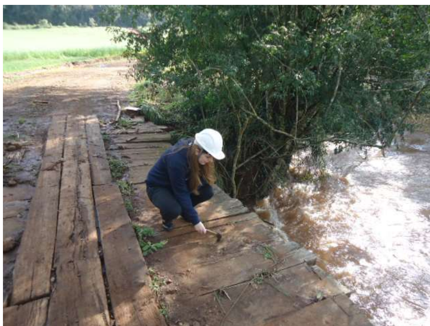
Figura 34 – Técnica de percussão: interpretação sonora com martelo da Ponte P001
