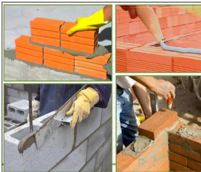
Figura 5 - Argamassa de Assentamento Fonte: Moraes (2013).
