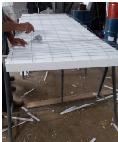
Figura 43: Confeção dos painéis de vedação de EPS Fonte: O AUTOR, 2017.
