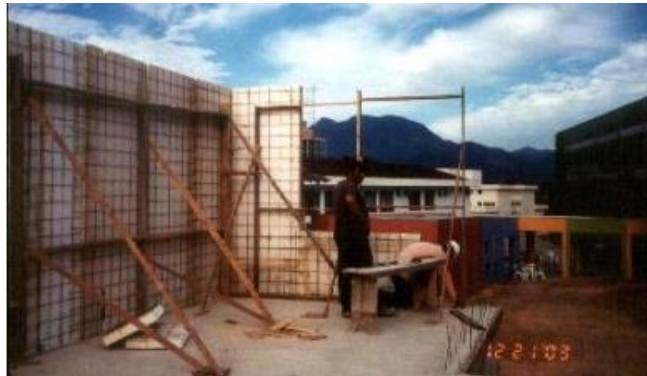
Figura 30: Escoramento dos painéis Fonte: LUEBKE, 2003.
