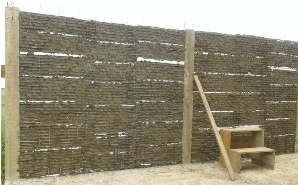
Figura 56: Primeira camada de revestimento Fonte: O AUTOR, 2017.
