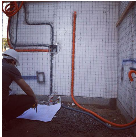
Figura 32: Instalação do sistema elétrico Fonte: MONOFORTE, 2016.
