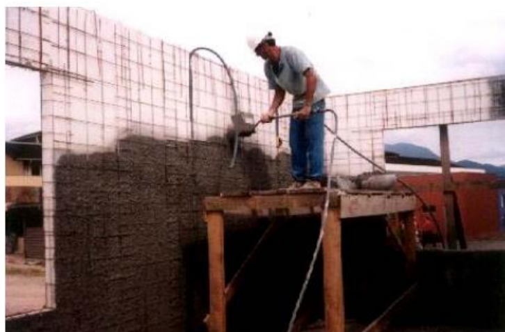
Figura 34: Aplicação da primeira camada de revestimento Fonte: LUEBLE apud LUEBKE, 2003.
