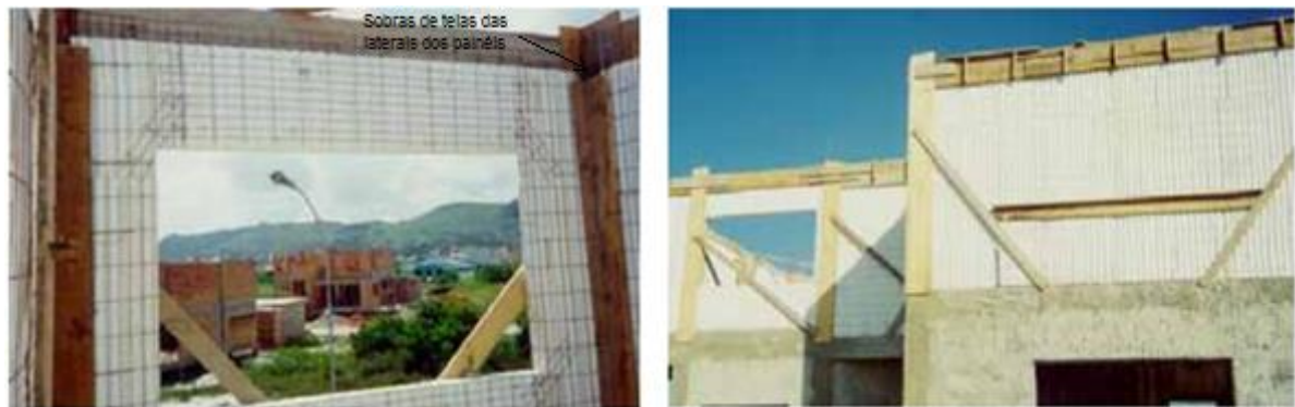
Figura 44: Painéis concretados com os pilares Fonte: BERTOLDI, 2007.
