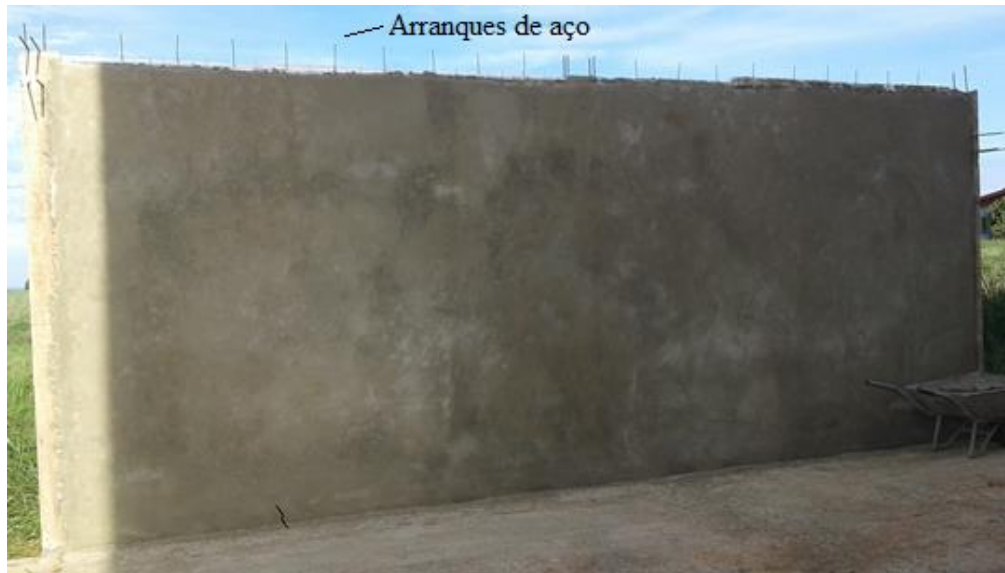
Figura 57: Parede com o revestimento de argamassa finalizado Fonte: O AUTOR, 2017.
