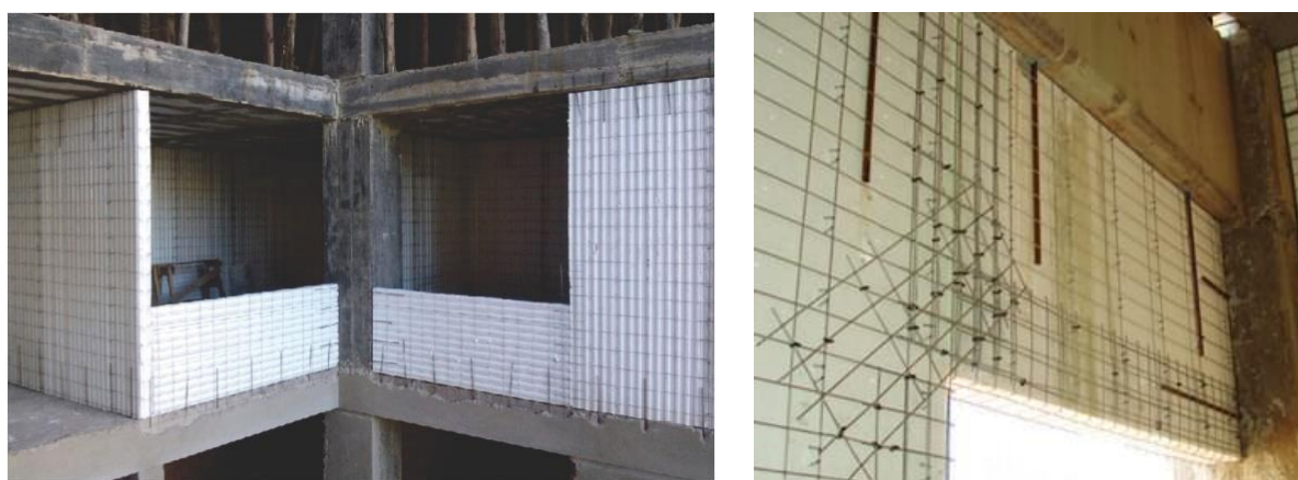
Figura 26: Arranques em vigas e lajes Fonte: TELAMARCK, 2016.
