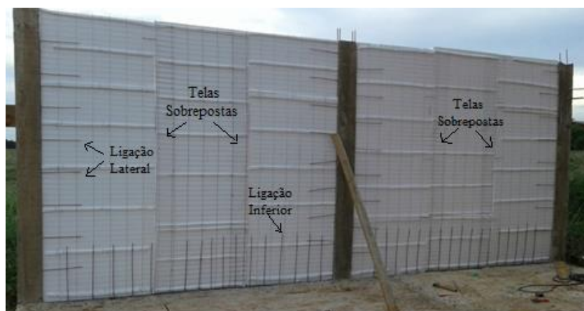
Figura 54: Painéis instalados Fonte: O AUTOR, 2017.
