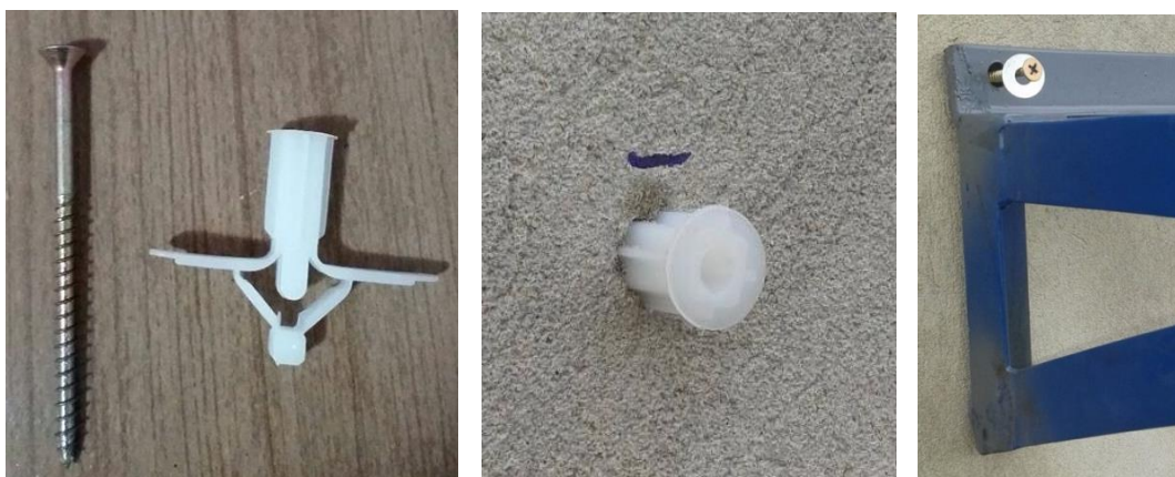
Figura 68: Instalação das buchas e fixação dos parafusos Fonte: O AUTOR, 2017.
