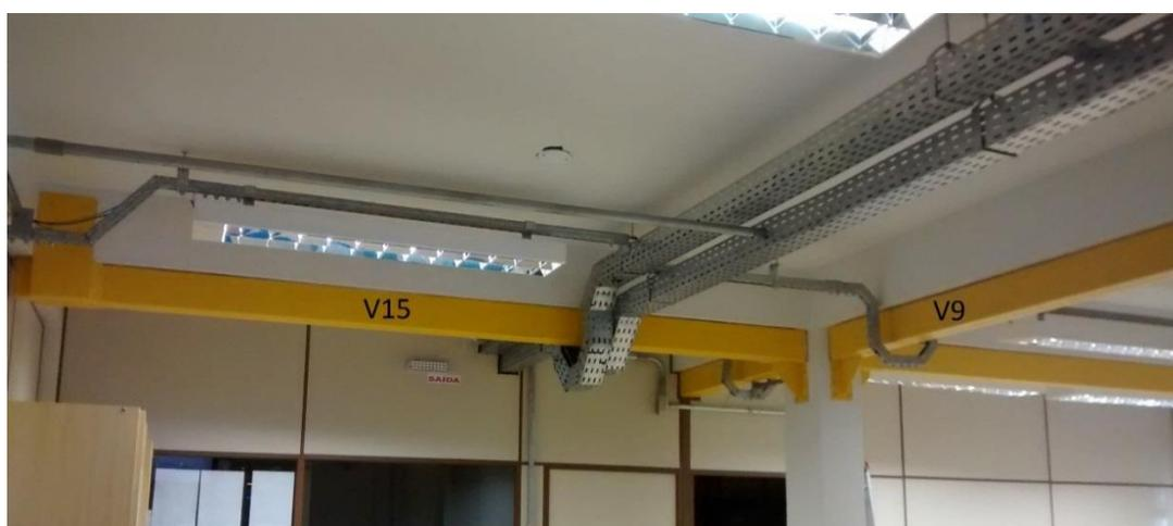
**Figura 17: V9 e V15 reforçadas com perfis de aço**
