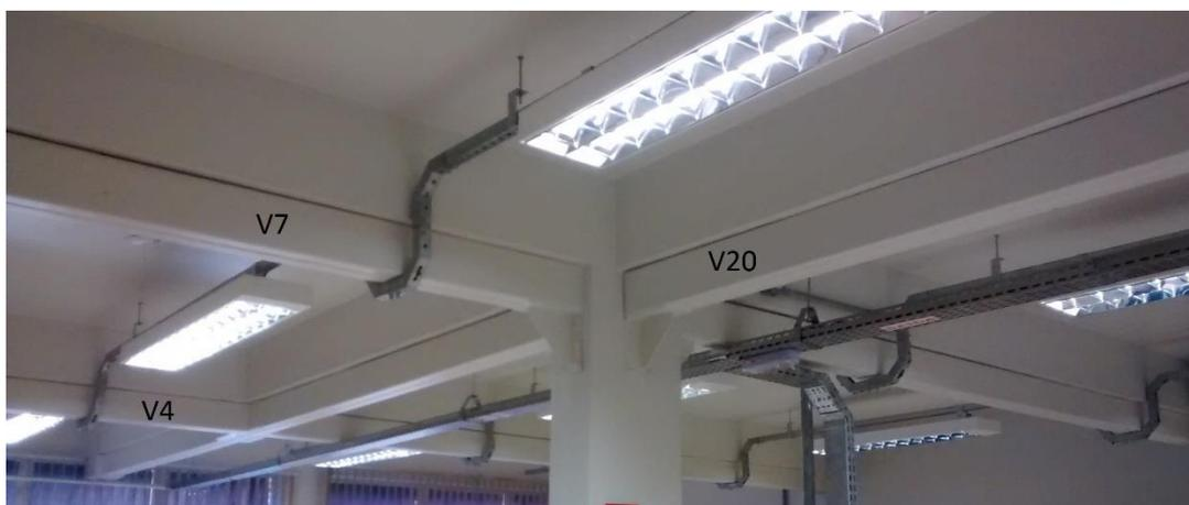
**Figura 16: V4, V7 e V20 reforçadas com perfis de aço**
