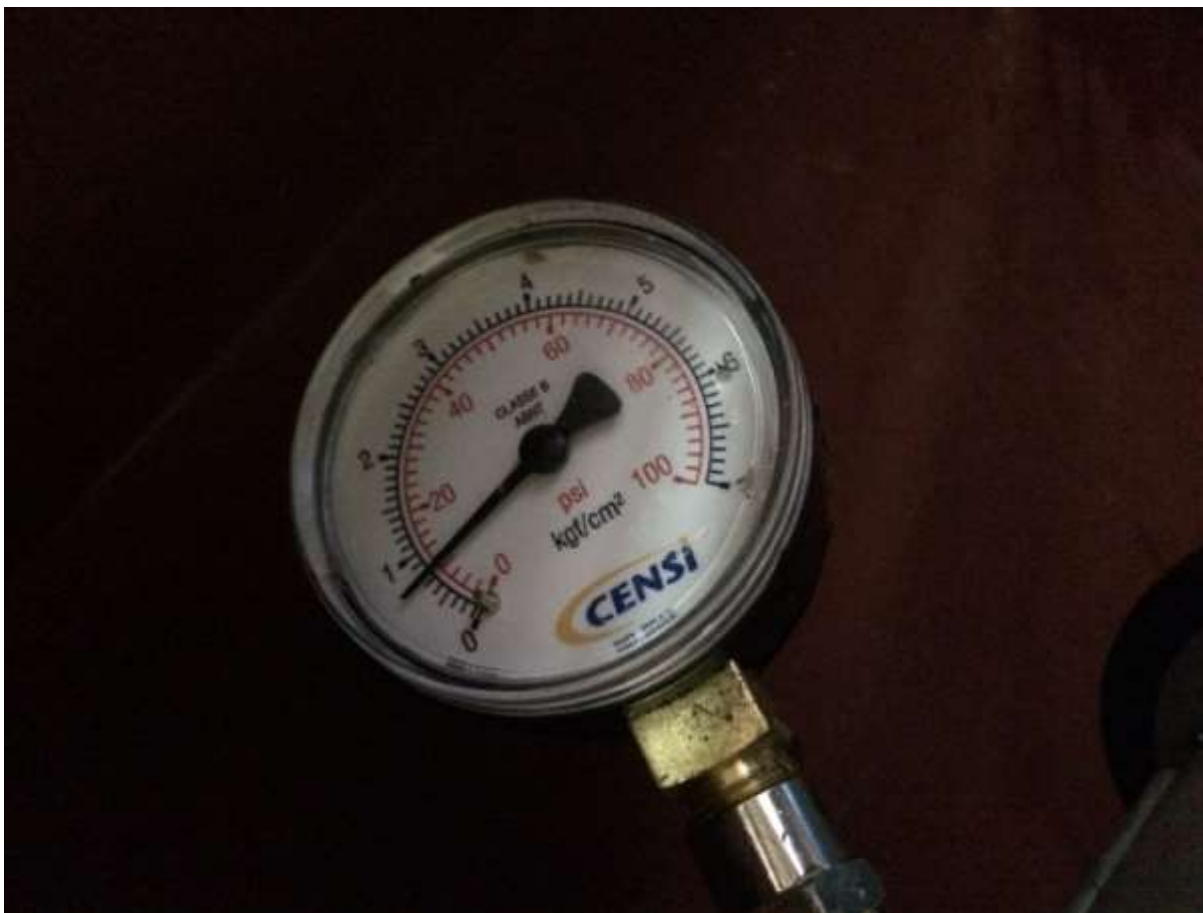
Foto 6: Valores do teste de vazão para o hidrante H-01. Fonte: Vasata, A. C. D. P. (2017).
