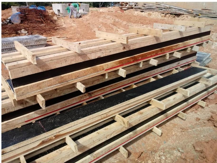
**Figura 7: Fôrmas para pilares com molde em compensado plastificado**
