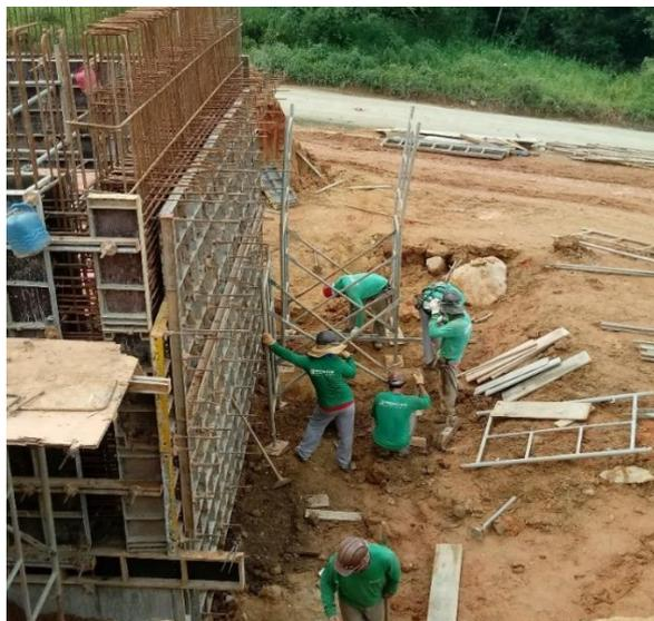
**Figura 31: Montagem de uma torre de andaime para escoramento de laje**
