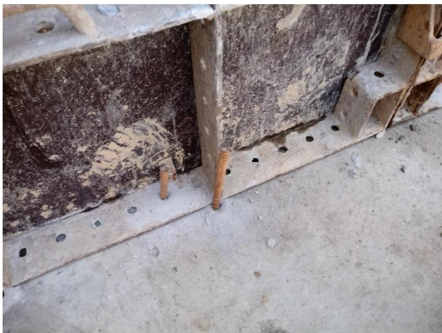
**Figura 29: Travamento de painel inferior com barras de aço**
