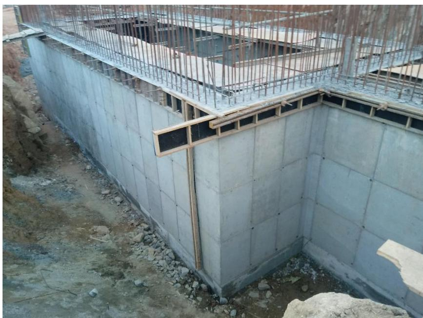
**Figura 32: Painéis de madeira confeccionados em obra para fechamento de vãos**
