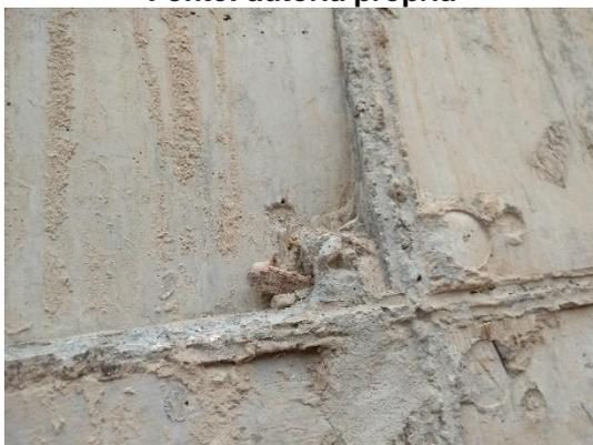
**Figura 36: Irregularidades no concreto devido a avarias nas fôrmas**
