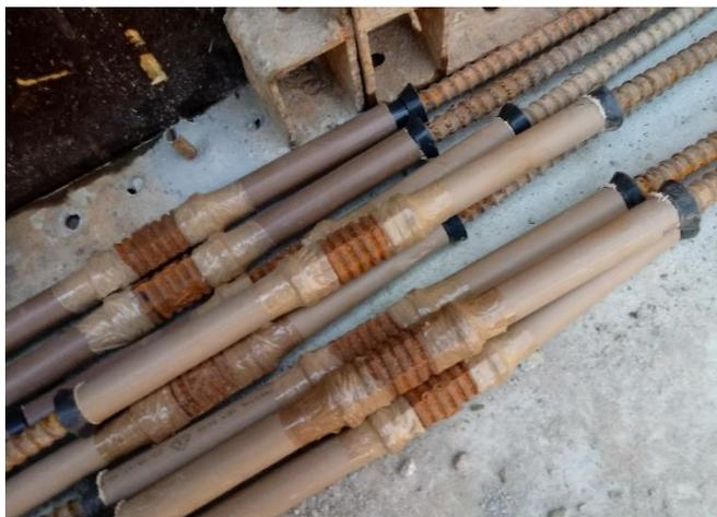
**Figura 28: Barras de ancoragem prontas para uso**
