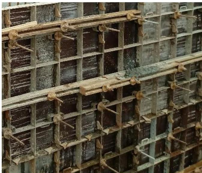
**Figura 27: Painéis reforçados com perfis metálicos**
