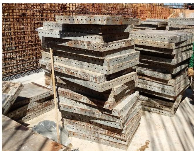
**Figura 15: Painéis de 90x90 empilhados**
