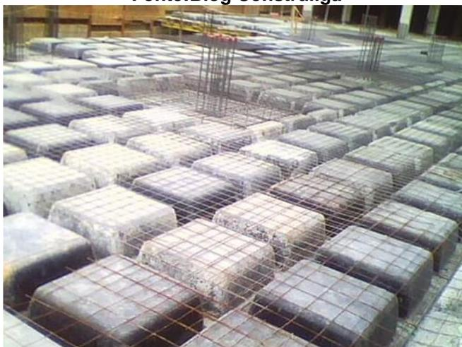
**Figura 9: Moldes para laje nervurada**
