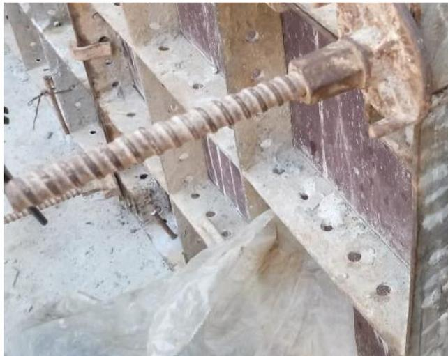
**Figura 23: Barra de ancoragem roscada**
