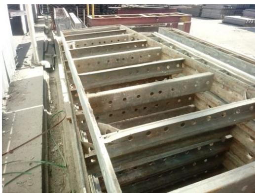
**Figura 10: Reforço metálico dos painéis**
