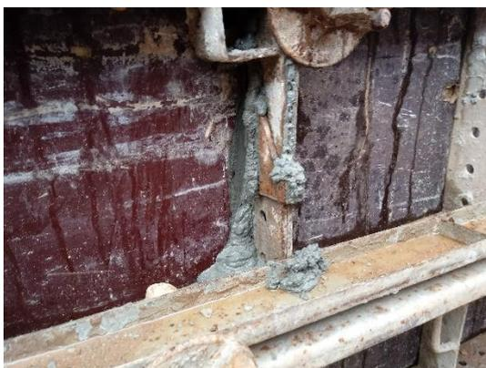
**Figura 35: Vazamento no encontro de painéis desalinhados**
