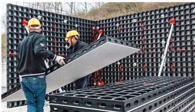
**Figura 8: Moldes de plástico liso**
