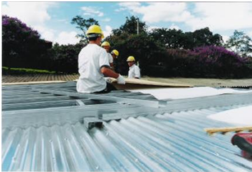
Figura 13: Forma metálica para laje úmida (Fonte: CRASTO, 2005)
