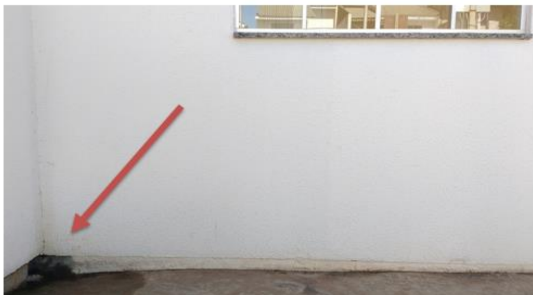
Figura 31: Abertura para escoamento de água da chuva. (Fonte: PERIN; MASSAROTTO, 2017)
