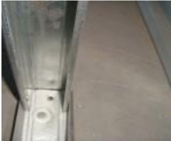
Figura 9: Guia e Montante. (Fonte: SILVA, 2012)
