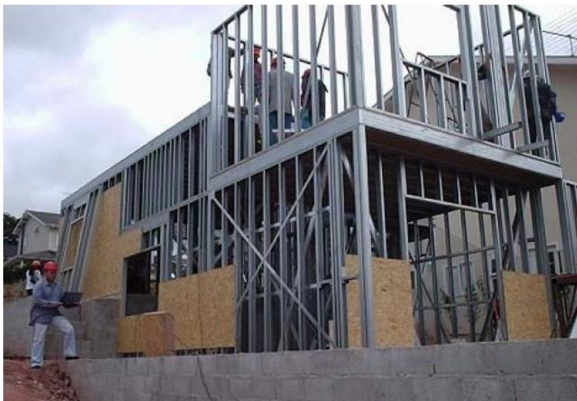
Figura 2: Exemplo de Edificação em LSF. (Fonte: BATISTA, 2011)
