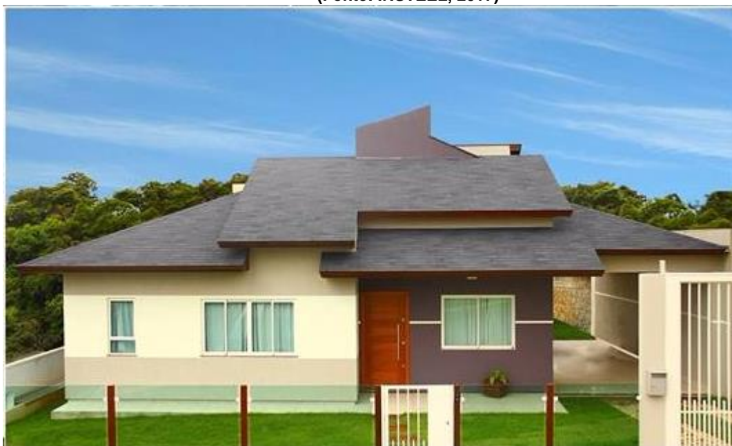
Figura 25: Fachada da Residência 2 em LSF. (Fonte: INSTEEL 2017)
