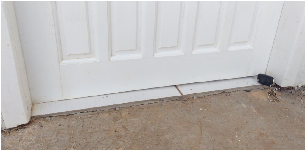
Figura 29: Fresta na Porta de Entrada da Casa 1 em LSF (Fonte: PERIN E MASSAROTTO, 2017)
