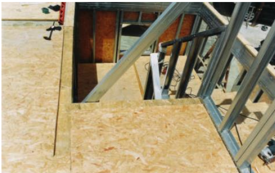
Figura 14: Placas de OSB utilizadas para laje seca (Fonte: CRASTO, 2005)
