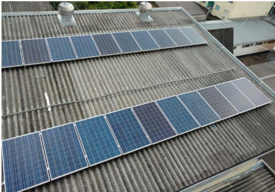
Figura 3 – Montagem dos painéis fotovoltaicos do sistema analisado. Fonte: Autoria própria.
