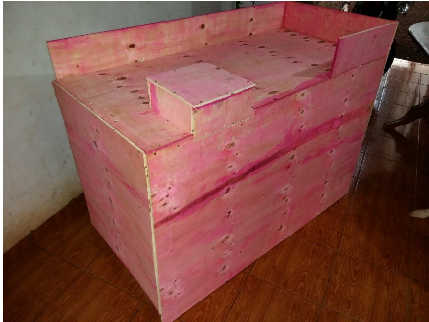
Figura 14 – fixação das chapas de madeirite.
