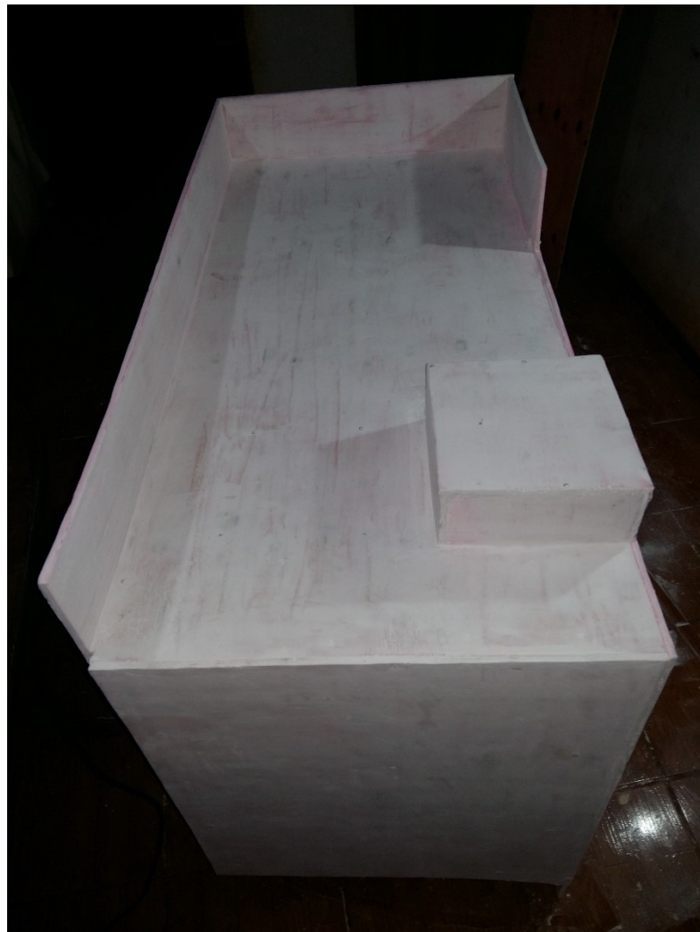
Figura 15 – Resultado obtido após a aplicação da massa corrida.
