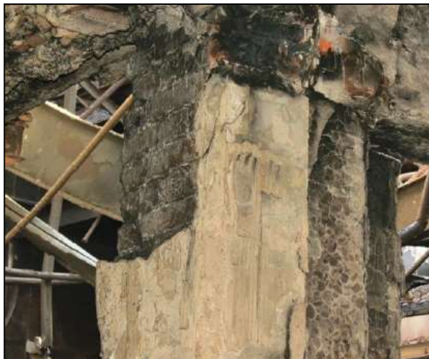
Figura 12 - Delaminação gradual do concreto, paletização 2º nível. Fonte: Laudo técnico - Empresa B.
