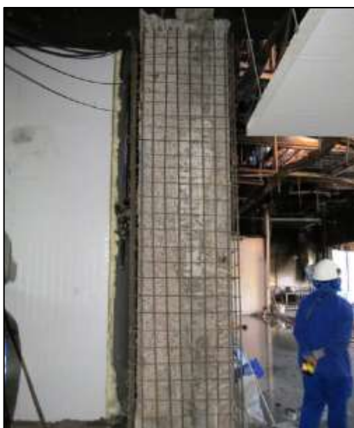
Figura 16 - Reparo de pilar, paletização 2º nível. Fonte: Laudo técnico - Empresa B.
