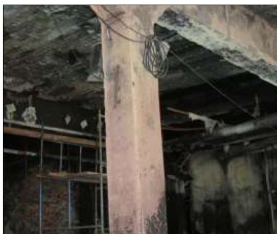
Figura 26 - Coloração do concreto, vermelho pálido, na paletização do 1º nível.
