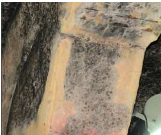
Figura 23 - Coloração do concreto amarelo alaranjado na paletização do 1º nível.
