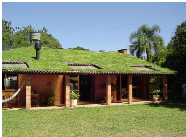
Figura 13 - Aplicação do telhado verde Fonte: Psico Ambiental (2011).
