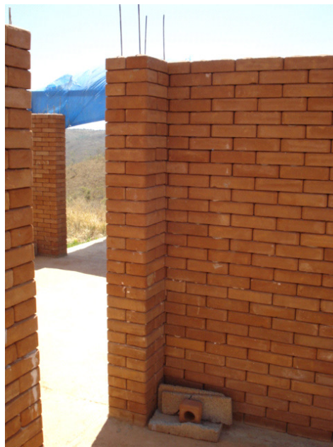
Figura 17 - Parede com tijolo de solo cimento Fonte: Modo Construção (2010).
