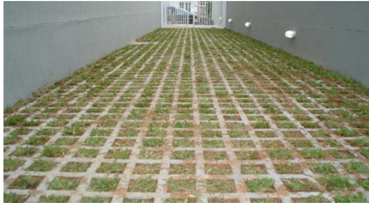
Figura 23 - Utilização de pisograma Fonte: Oterprem (s.d.).
