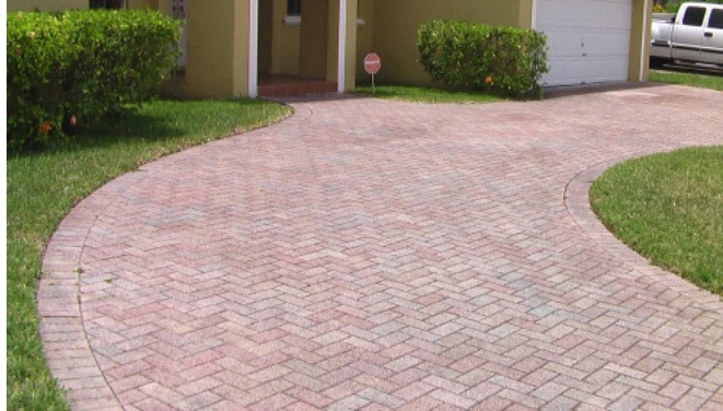
Figura 21 - Pavimento intertravado Fonte: Pisos Darciel (s.d.).
