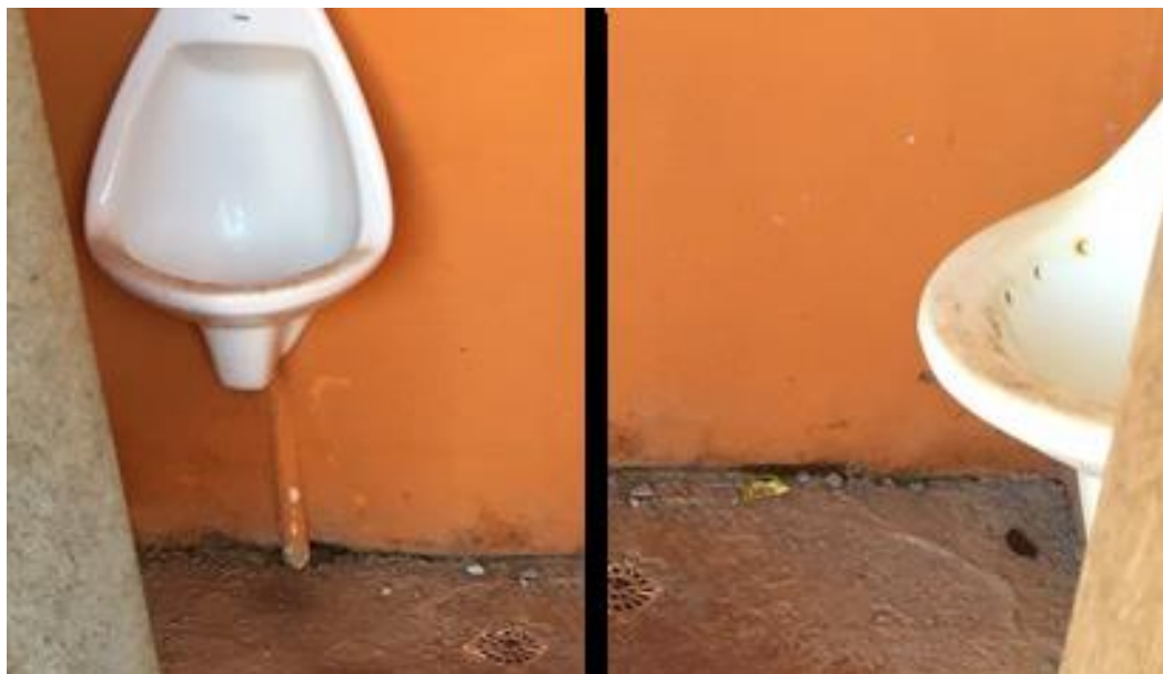
Figura 4. Instalações sanitárias, obra C. Fonte: Autora, 2015.
