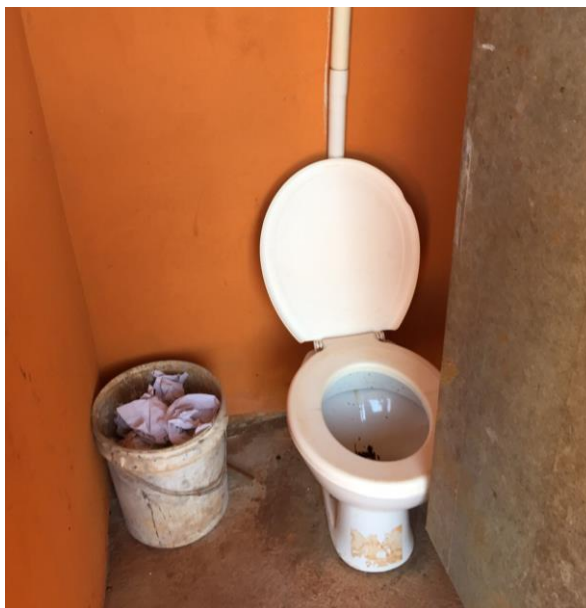
Figura 6. Gabinete sanitário, obra C. Fonte: Autora, 2015.
