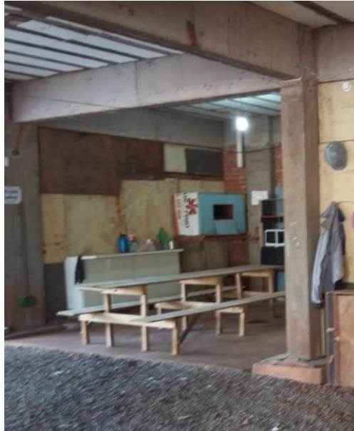
Figura 13. Refeitório sem paredes, obra H. Fonte: Autora, 2015.
