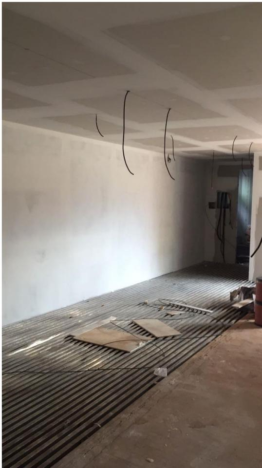
**Figura 20 - Revestimento em gesso acartonado**
