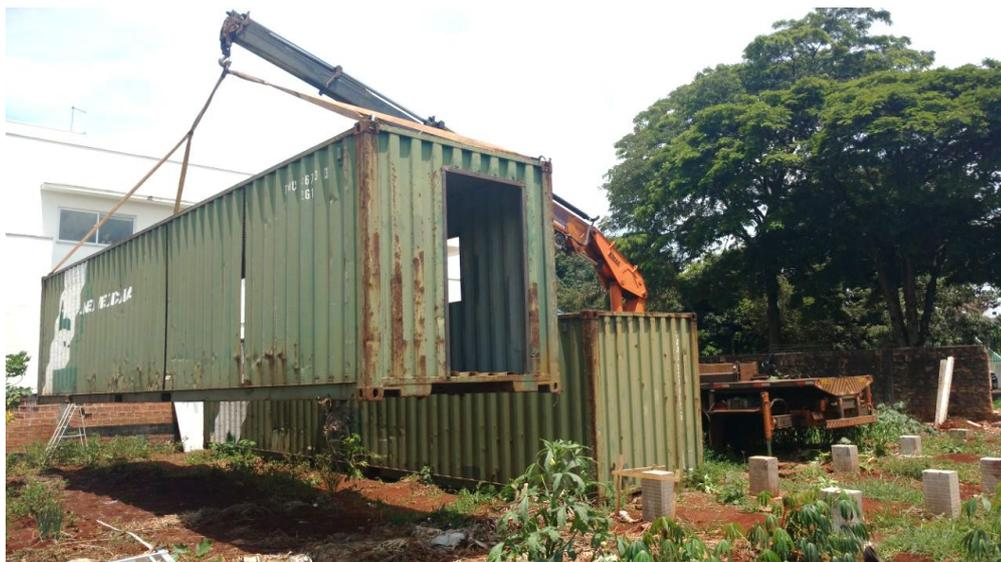
**Figura 10 - Posicionamento de Contêiner sobre Fundação**
