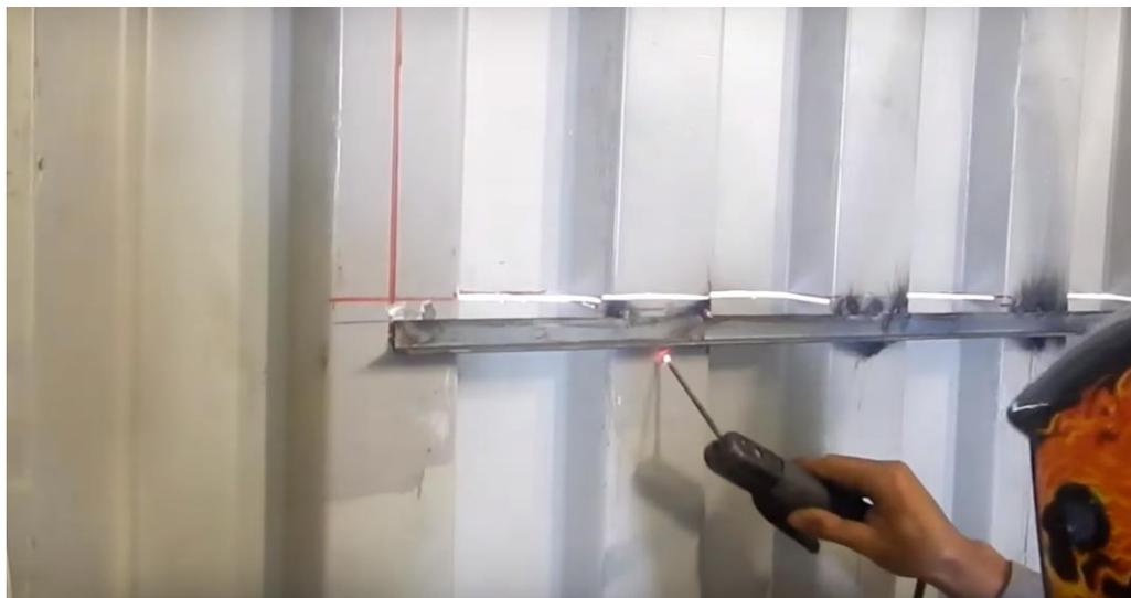
**Figura 12 - Solda de Reforço para recorte de janela**
