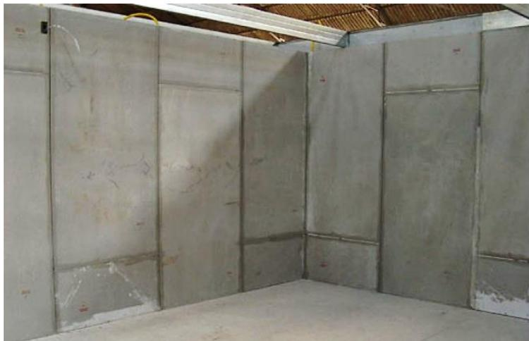
**Figura 21 - Parede com revestimento em placa cimentícia**
