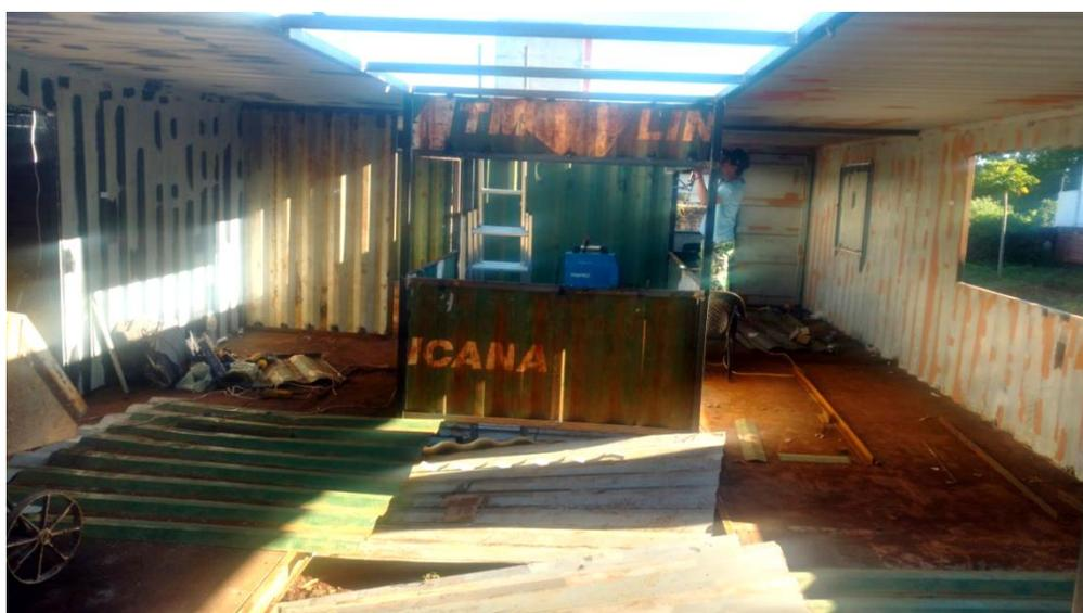
**Figura 11 - Reforço Estrutural Interno**
