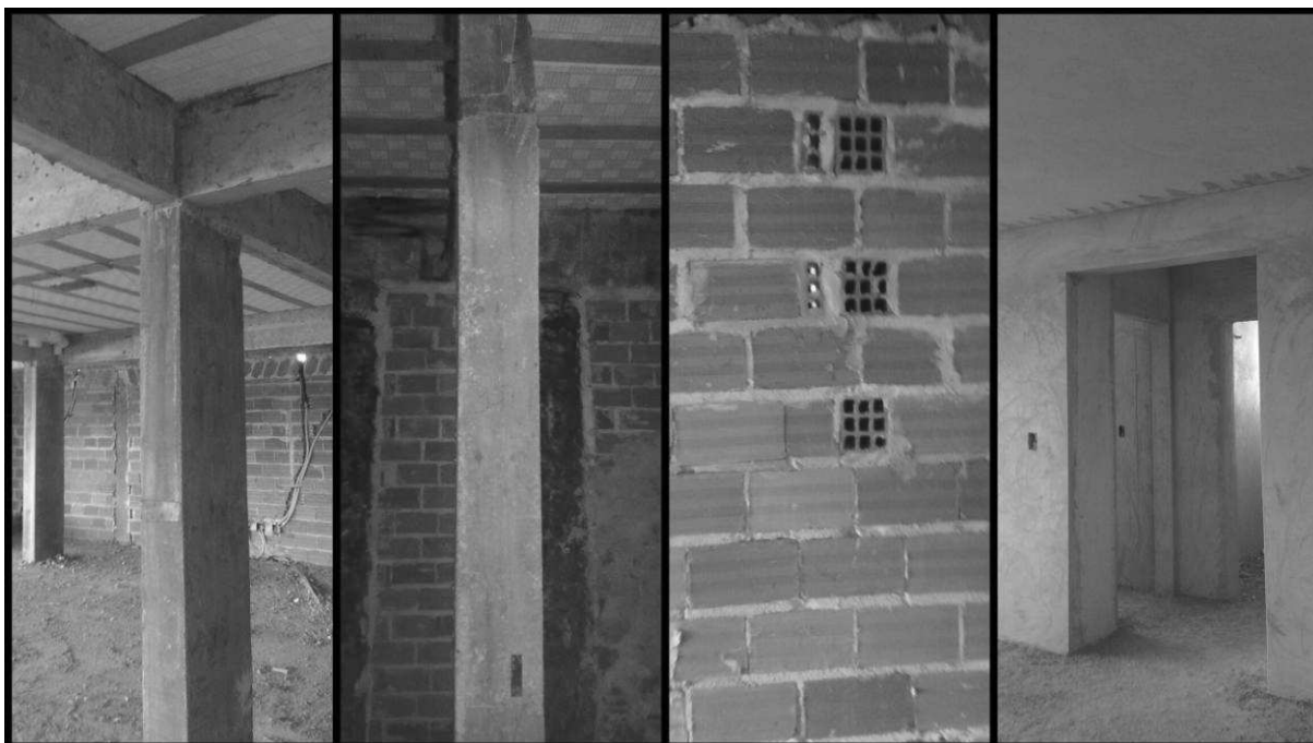
Figura 15 - Edificação no dia 04/05/2016 Fonte: A autora (2016).
