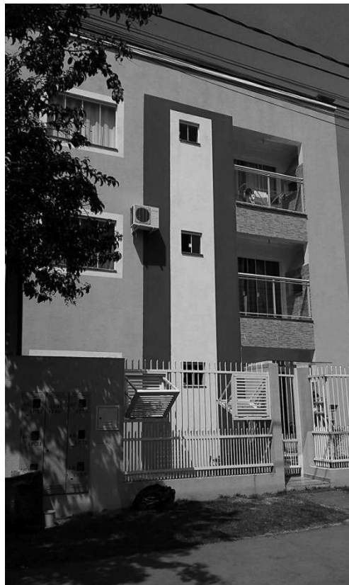
Figura 18 – Fachada do edifício Fonte: A autora, 2017
