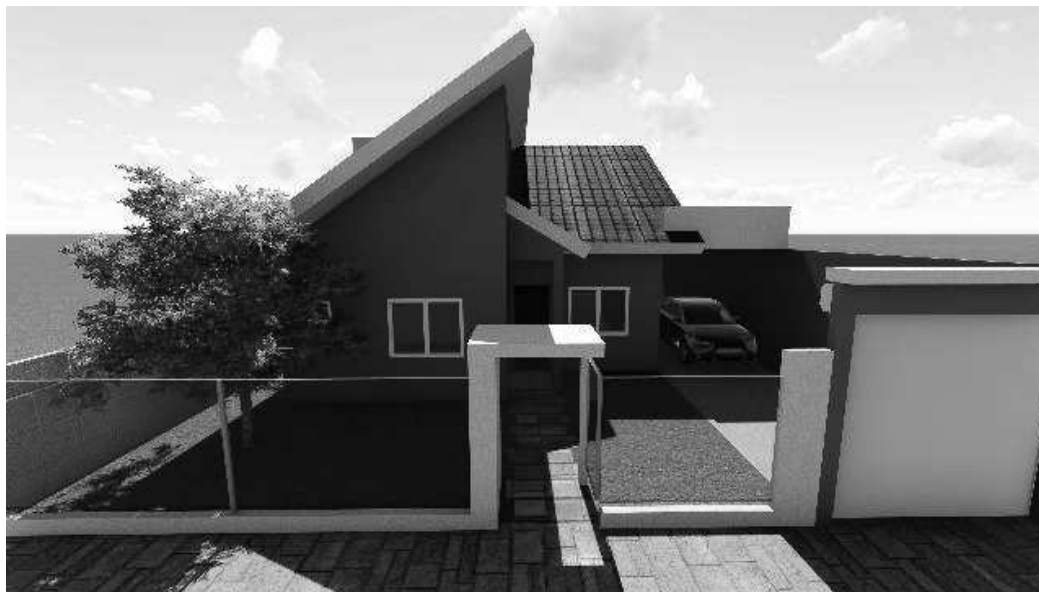
Figura 4: Fachada da residência objeto de estudo.
