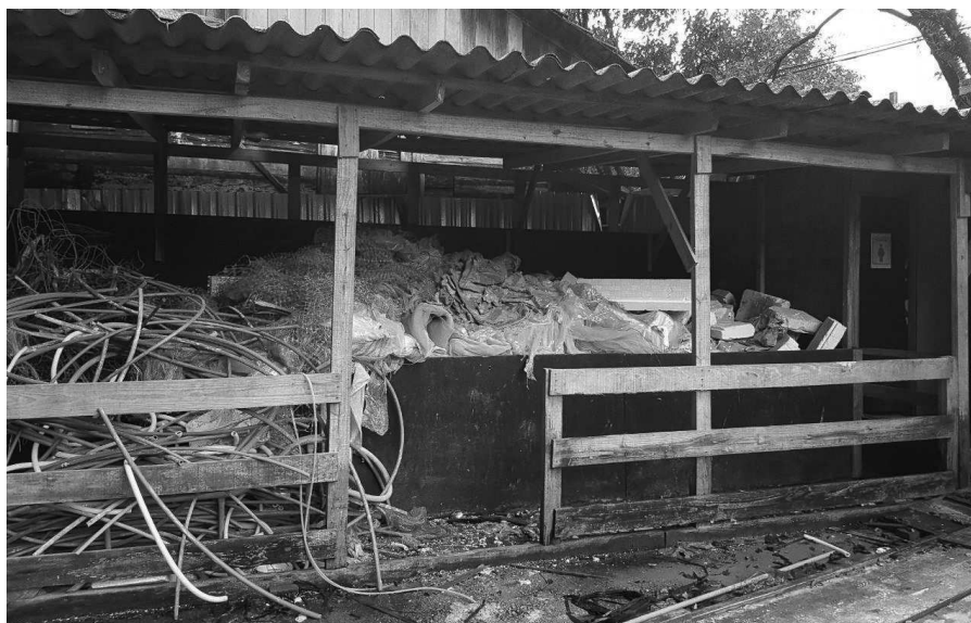
Figura 10. Baias para acondicionamentos de resíduos, não identificados e sem triagem.
