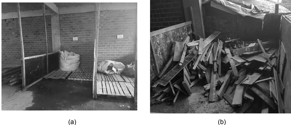
Figura 4. Baias de acondicionamento de RCCs. (a) Da esquerda para a direita, madeira depositada para reutilização, baia de resíduos classe C, baia de resíduos classe B (plástico, papel e vidro). (b) Baia de resíduos classe B, madeira.
