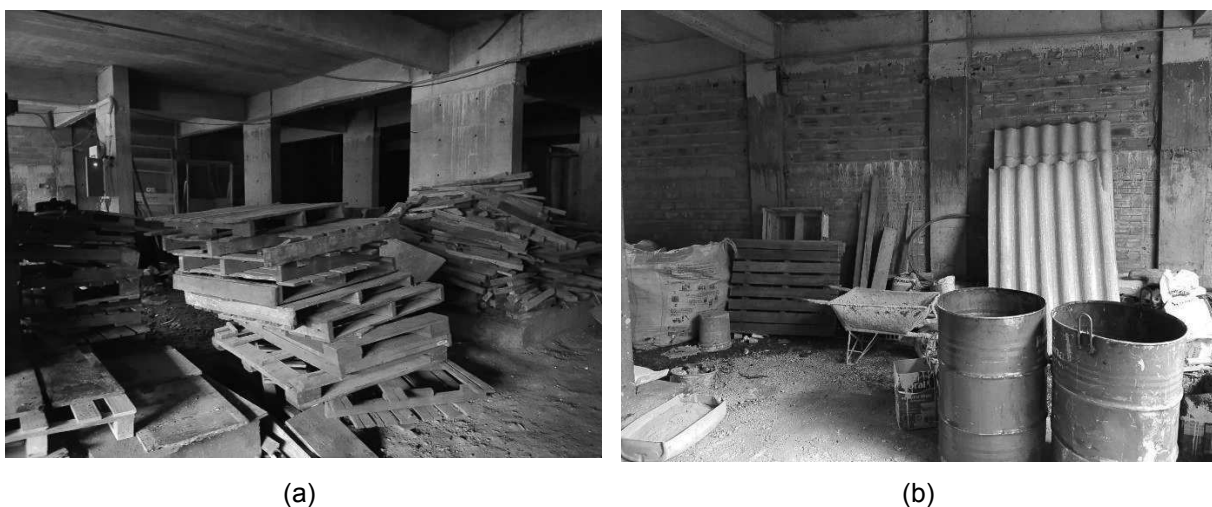
Figura 7. Estocagem de material. (a) Estocagem desorganizada de restos de madeira e paletts . (b) Estocagem de diversos tipos de materiais, juntamente com resíduos, em área de circulação.
