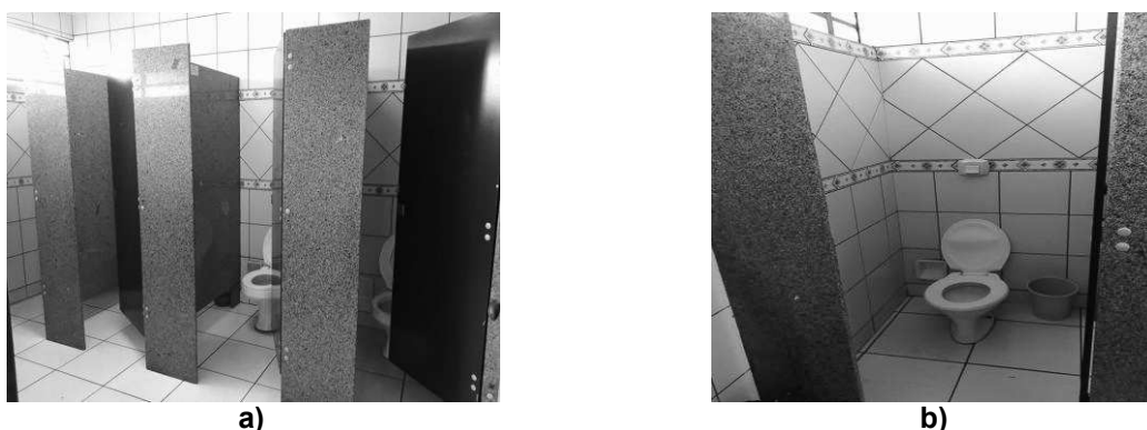
Figura 38 - a) Sanitário coletivo sem boxe acessível; b) Boxe inacessível Fonte: Aatoria própria (2017).
