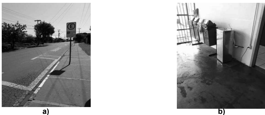
Figura 36 - a) Sinalização incompleta de vaga P.N.E.; b) Bebedouro em desconformidade com a norma
