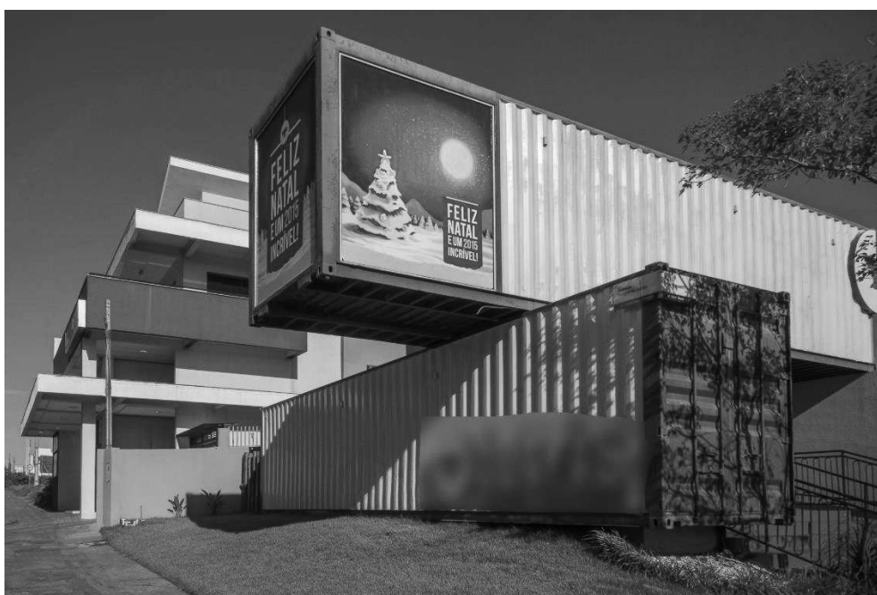
Figura 10 - Vista da fachada da Edificação A Fonte: Leo Cavallini (2015).
