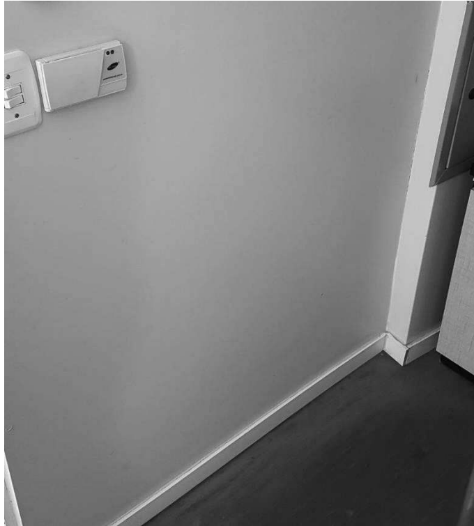
Figura 11 - Interior da edificação revestido com Dry Wall Fonte: Autoria Própria.
