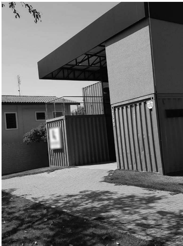
Figura 12 - Vista da fachada da Edificação B Fonte: Autoria Própria.
