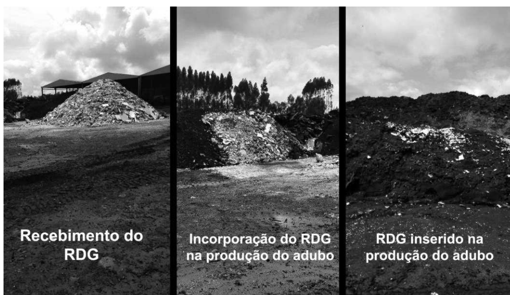
Figura 16 - Etapas da reciclagem do gesso em empresa de compostagem no município de Cascavel Fonte: Elaborado pelo autor, 2017
