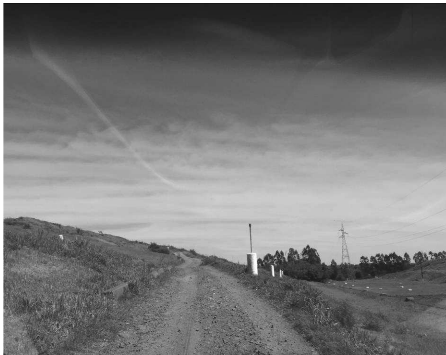
Figura 20 - Utilização do RCC para melhoramento de estradas internas do Aterro Municipal de Foz do Iguaçu Fonte: Elaborado pelo autor, 2017
