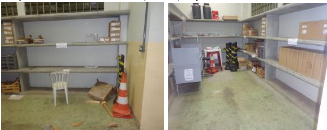
Fotografia 1 - Almoxarifado, antes e depois da aplicação dos senso
