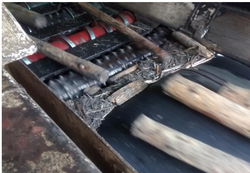
Figura 23 Sujeira final da correia transportadora
