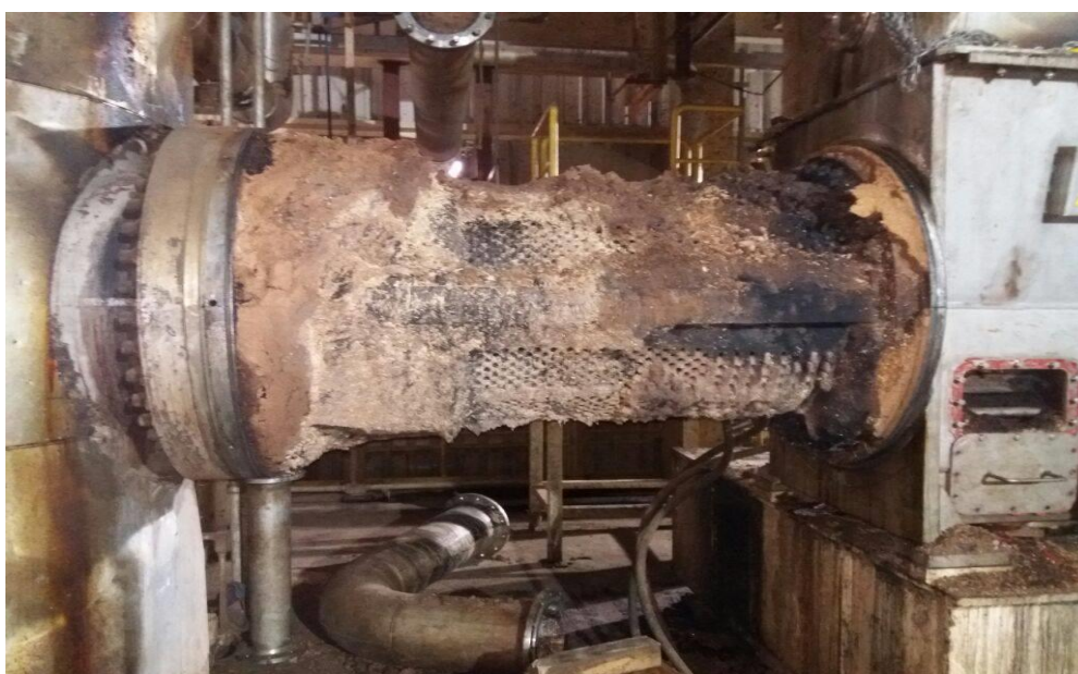
Figura 10 Rosca plug aberta para manutenção
