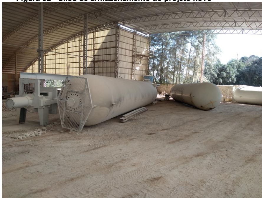
Figura 32 - Silos de armazenamento do projeto novo
