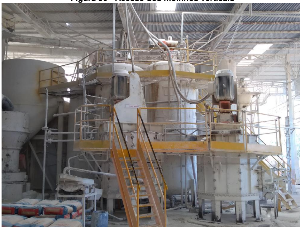
Figura 30 - Acesso dos moinhos verticais
