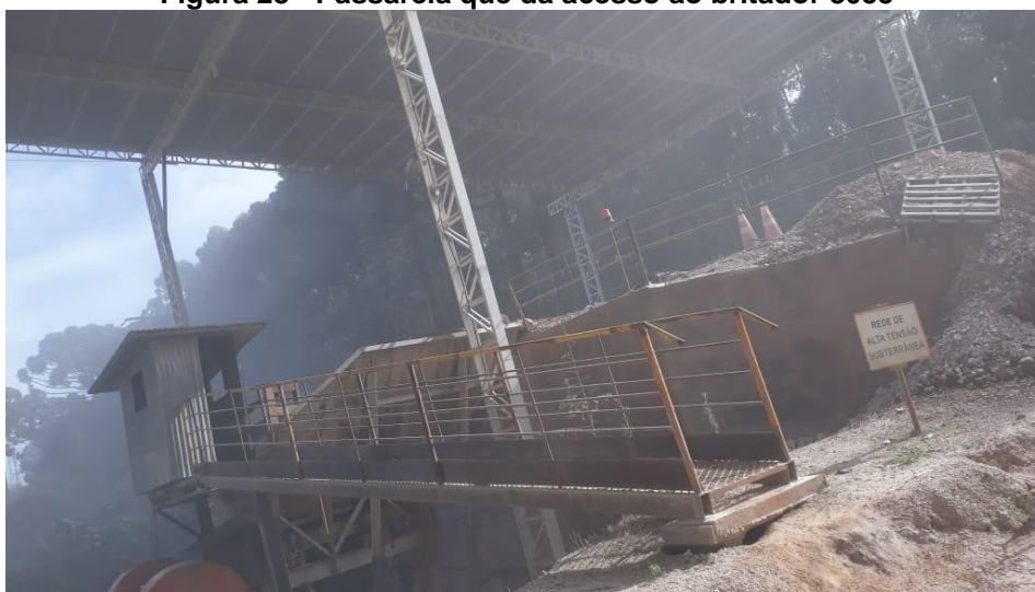
Figura 28 - Passarela que dá acesso ao britador 8055
