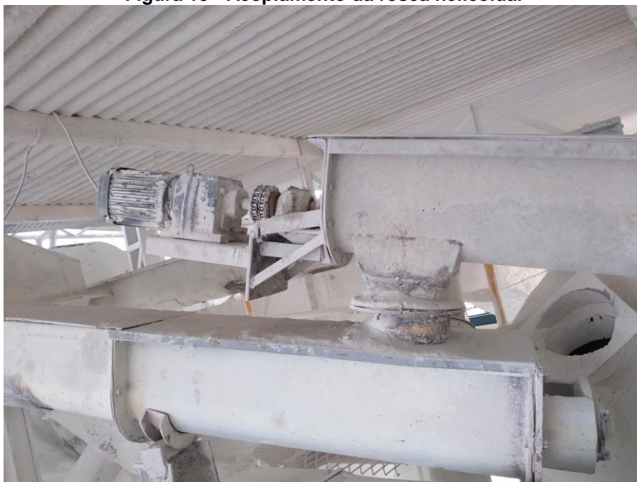
Figura 15 - Acoplamento da rosca helicoidal
