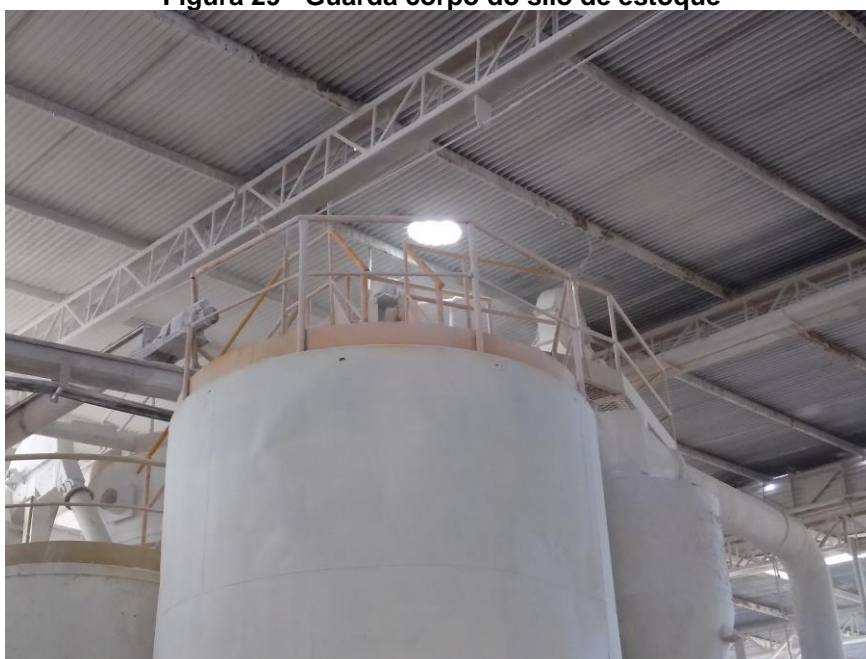
Figura 29 - Guarda corpo do silo de estoque
