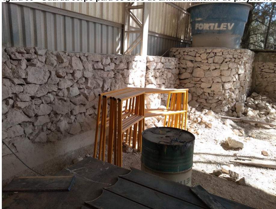
Figura 33 - Guarda corpo para os silos de armazenamento do projeto novo
