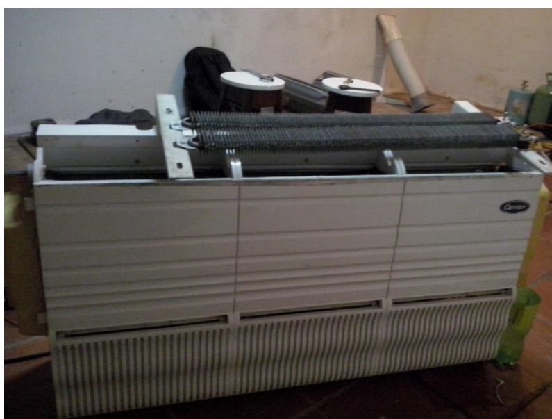
Figura 12 - Evaporador e resistência.
