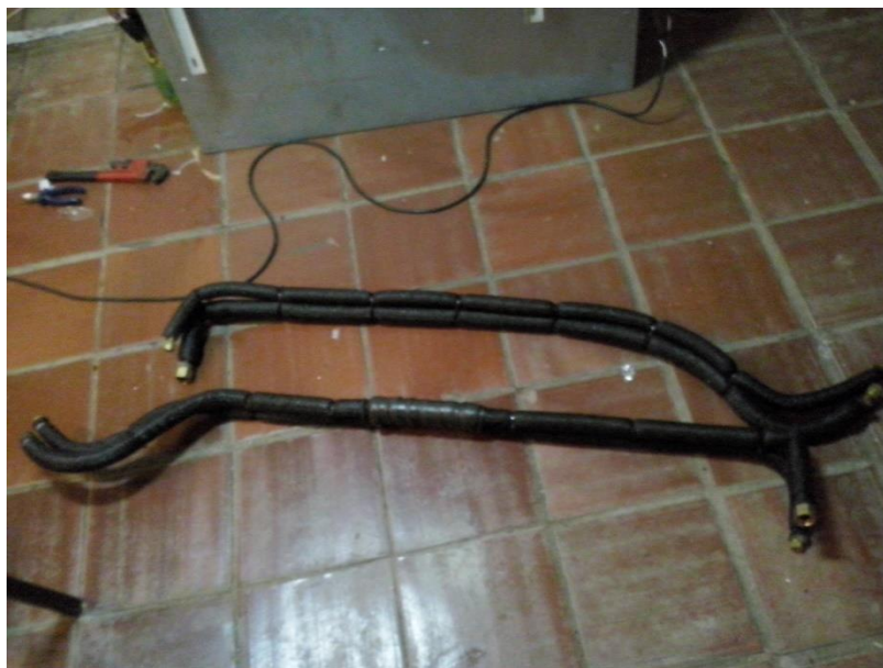
Figura 21 - Tubulações de teste previamente preparadas.
