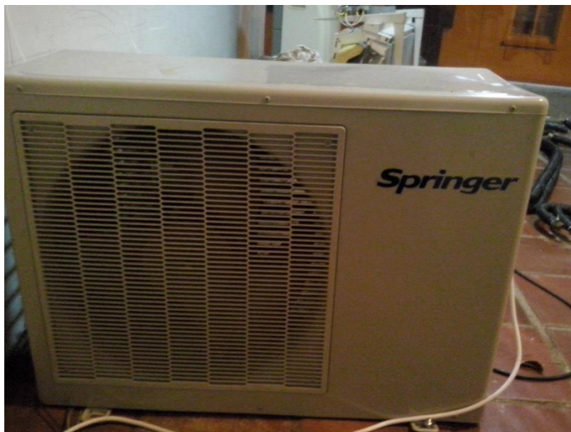
Figura 11 - Unidade condensadora.
