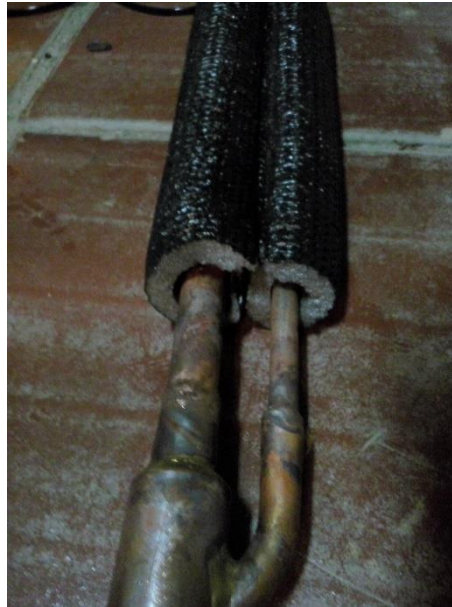
Figura 18 - SLHX e isolante térmico.
