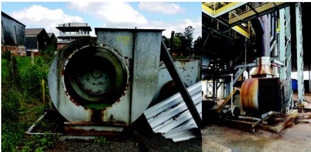
Figura 10 – Ventilador secundário antes e após reforma e instalação
