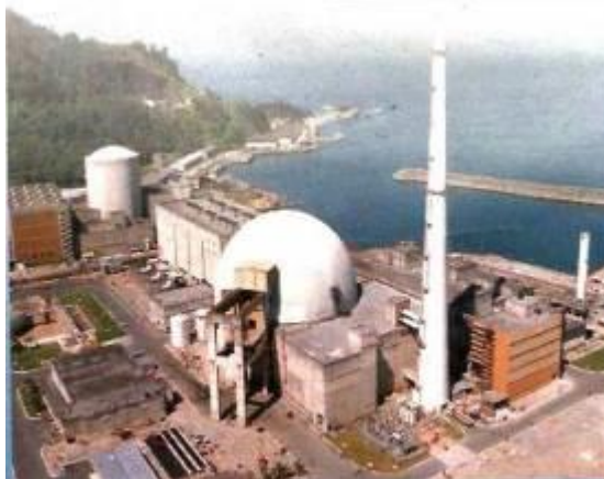
Complexo Termoeletric Angra (RJ) Aerov. Eletromecânica
