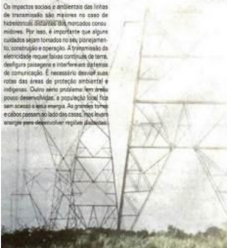
Torre de transmissão João Farias
