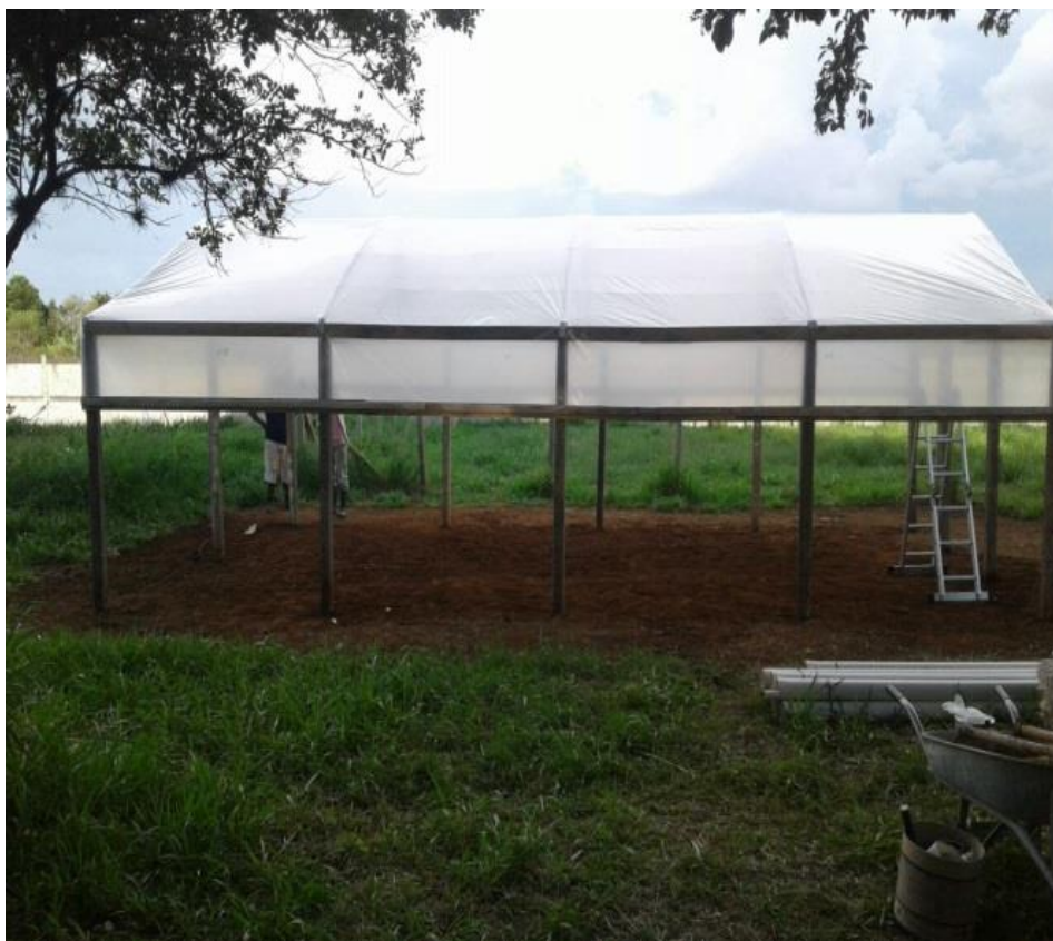
Figura 3- Finalização da instalação do filme plástico:
