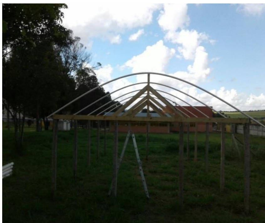
Figura 1: Estrutura inicial da cobertura
