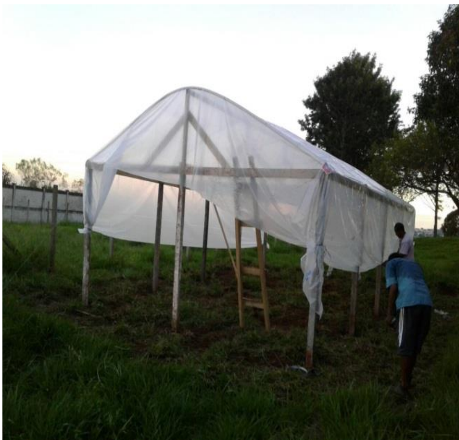
Figura 2- Etapa inicial da colocação do filme plástico:
