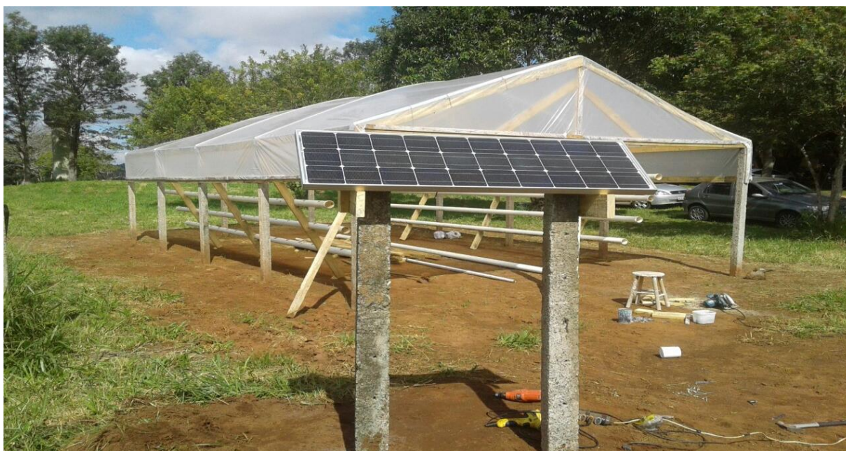
Figura 8- Instalação da placa fotovoltaica:
