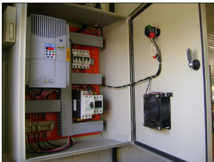
Fotografia 4: Painel com os componentes instalados Fonte: Autoria própria
