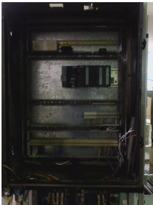
Figura 60: Foto começo da montagem do painel Fonte: Autoria própria
