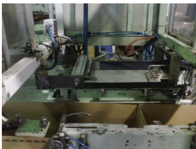
Figura 47: Foto interior robô desmontado Fonte: Autoria própria
