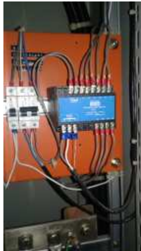
Figura 18 – Transdutor MKM-01 - KRON Fonte: Aatoria própria (2016)
