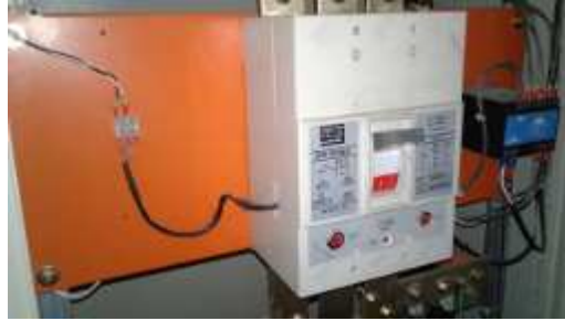
Figura 17 – Disjuntor DW 800NA - Weg Fonte: Aatoria própria (2016)
