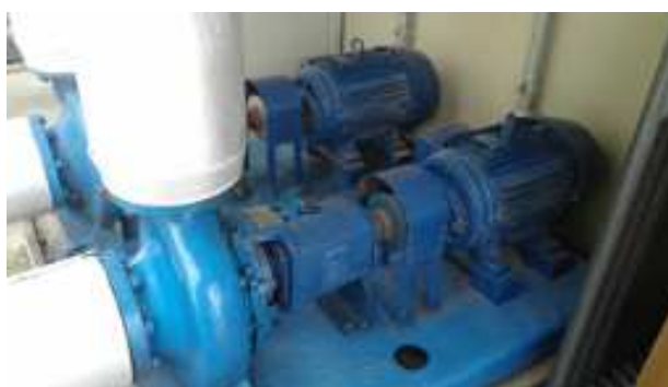
Figura 6 – Bombas Secundárias Fonte: Aatoria própria (2016) (2016)
