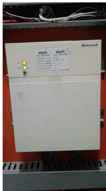
Figura 1 – Controlador XL10 - Honeywell Fonte: Autoria própria (2016) (2016)
