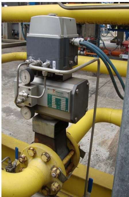
Figura 13 - Válvula borboleta com atuador pneumático. Fonte: Aatoria própria.
