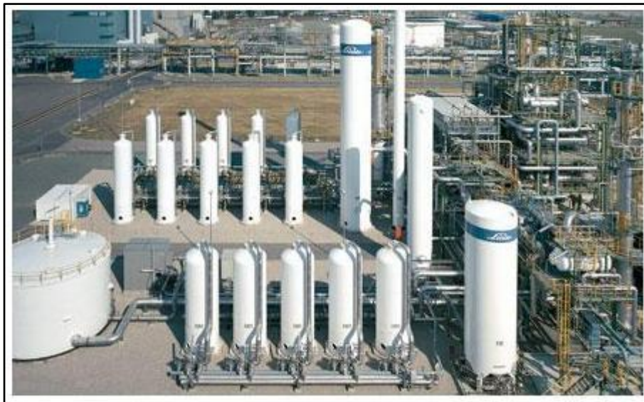
Figura 44 – PSA aplicada ao setor petroquímico na purificação de hidrogênio. FONTE: LINDE AG, 2012.
