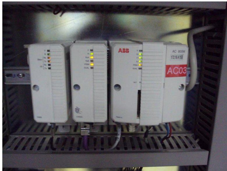
Figura 15- CPU Modelo PM864 ABB Fonte: Autor
