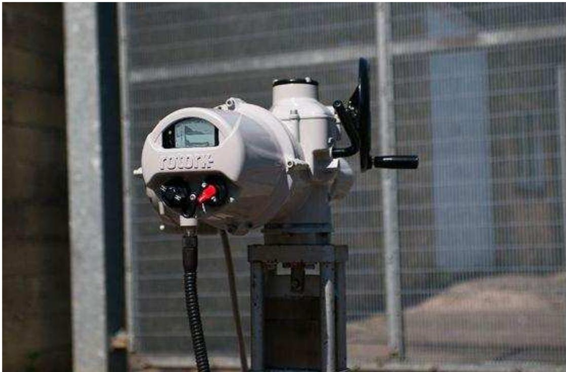
Figura 6: Atuador elétrico aplicado em válvula do tipo guilhotina.
