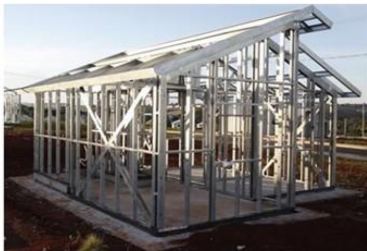
Figura 5 – Montagem dos perfis metálicos do Sistema Light Steel Frame Fonte: FNDE/Proinfância, 2016
