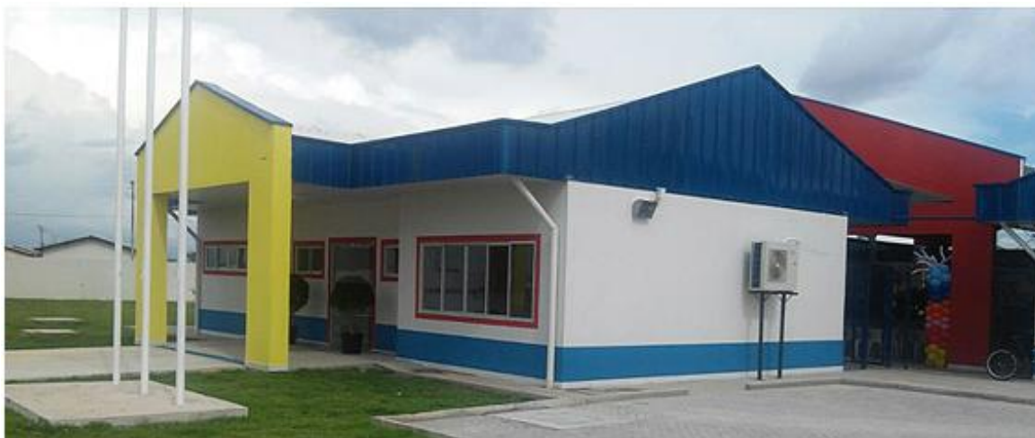
Figura 15 – Creche executada em Light Steel Frame em Boa Vista-RR Fonte: Metálica, 2016
