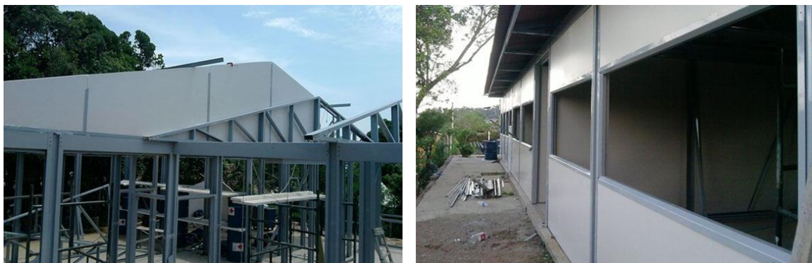
Figura 3 – Montagem creche em Porto Alegre no Sistema Painel Wall System Fonte: Arquivo MVC Soluções em Plásticos, 2016
