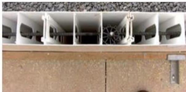
Figura 12 – Posicionamento das armaduras no painel de PVC Fonte: TÉCHNE, 2013
