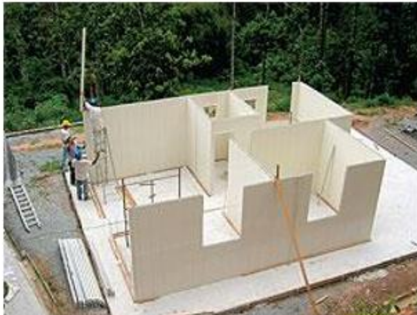
Figura 11 – Montagem dos painéis de PVC Fonte: ESPECIALIZE, 2014
