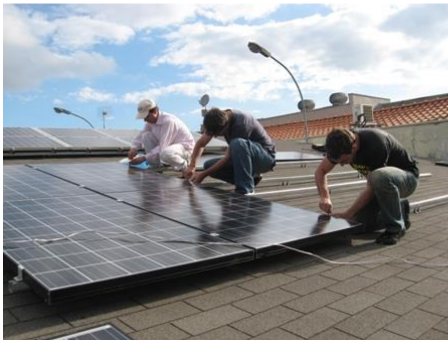
Figura 17: Instalação do SFVCR no telhado do Escritório Verde
