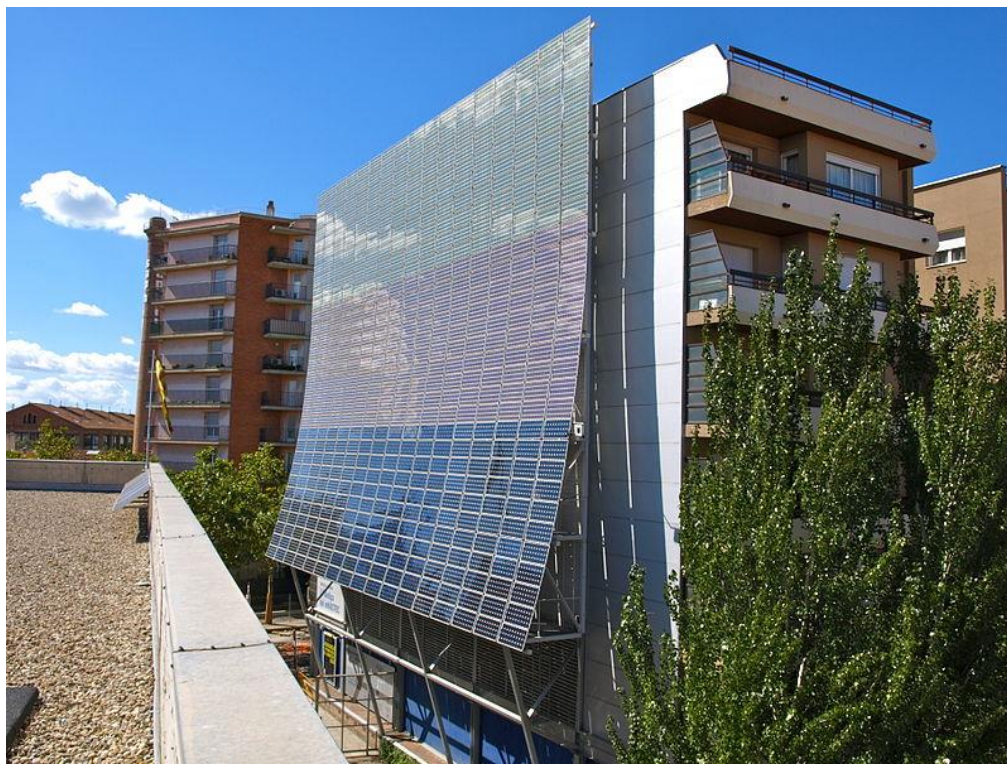
Figura 8: Exemplo de BAPV – Fachada fotovoltaica aplicada do edifício MNACTEC (Tarrasa, Espanha).
