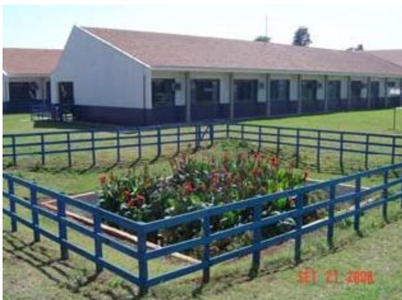
Figura 02 – Estação de tratamento de esgoto por zona de raízes
