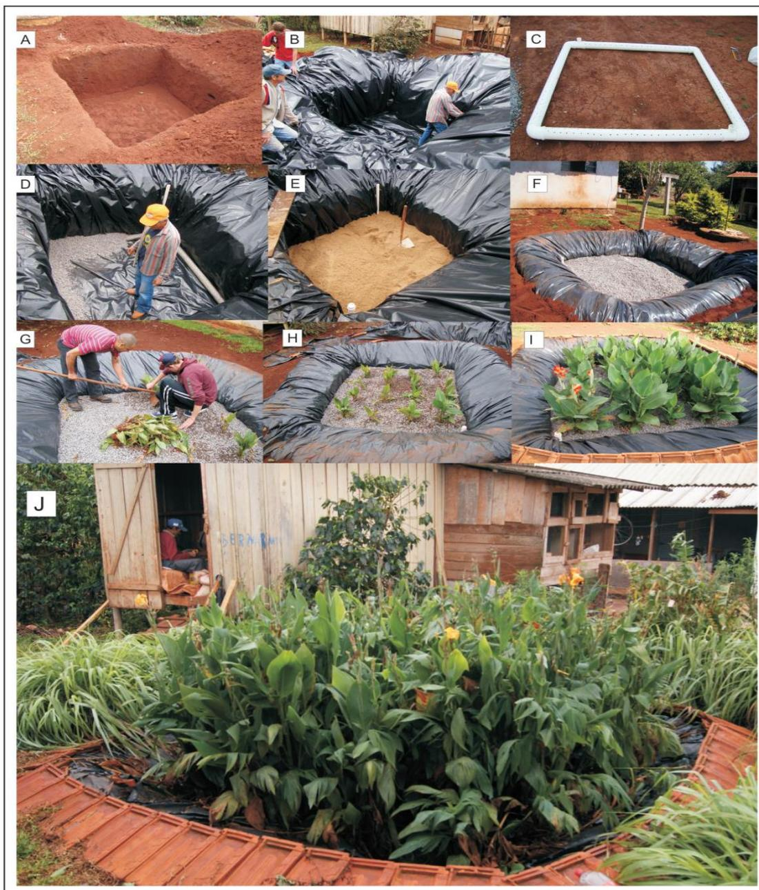
Figura 15 – Etapas de construção de um *wetland* construído
