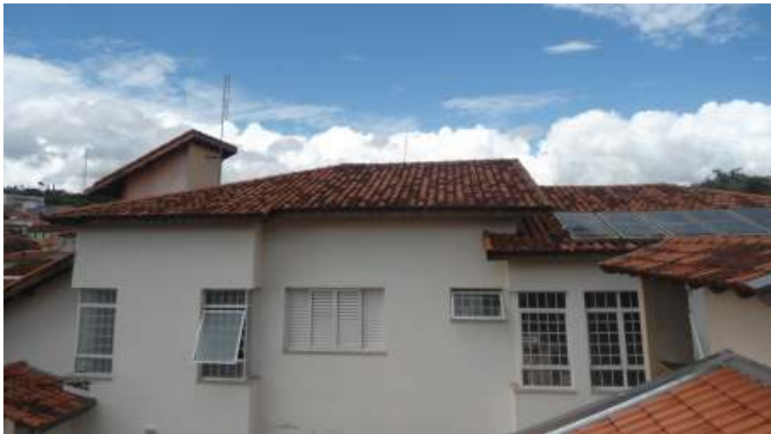
Figura 15 – Foto do telhado voltado para o norte Fonte: Proprio autor.
