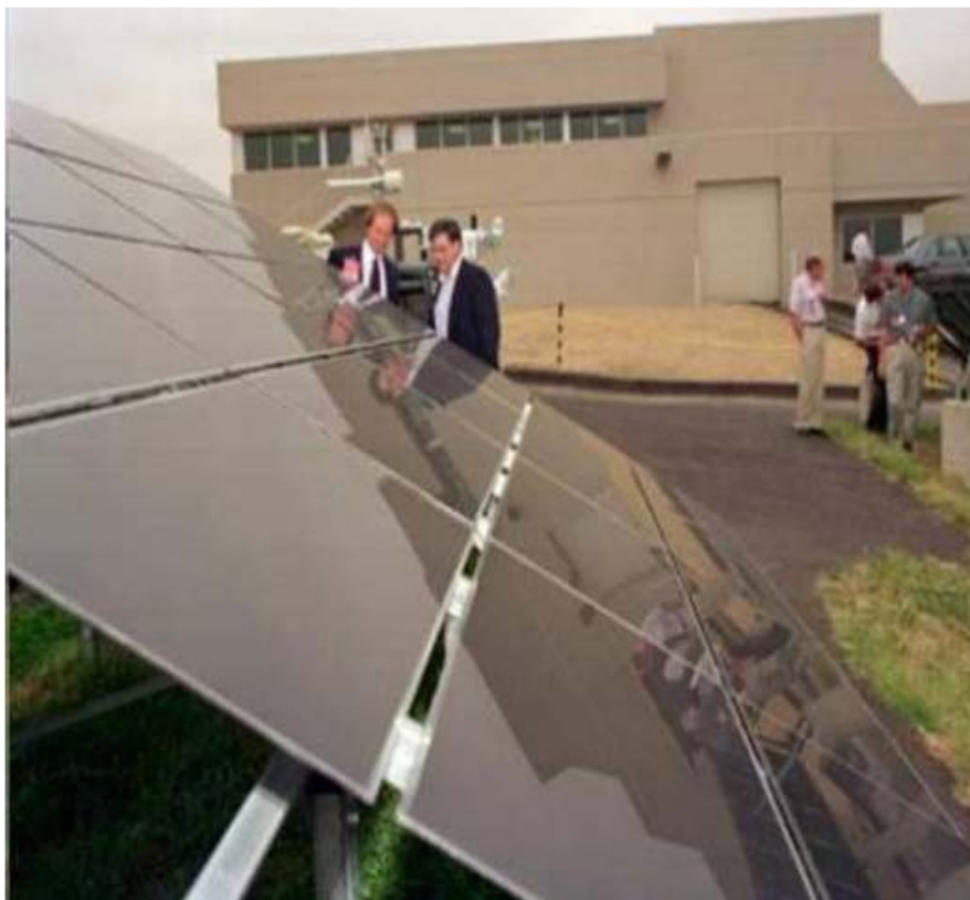
Figura 6 –Módulo de Filmes Finos de CdTe. Fonte: (RÜTHER, 2004)
