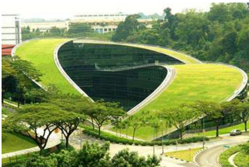
Figura 5. Telhado verde extensivo da Escola de Arte, Design e Multimídia – Universidade Tecnológica de Nanyang, em Cingapura
