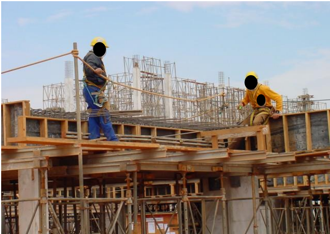
FIGURA 12 – CANTEIRO DE OBRAS 5 Fonte: O Autor (2017)
