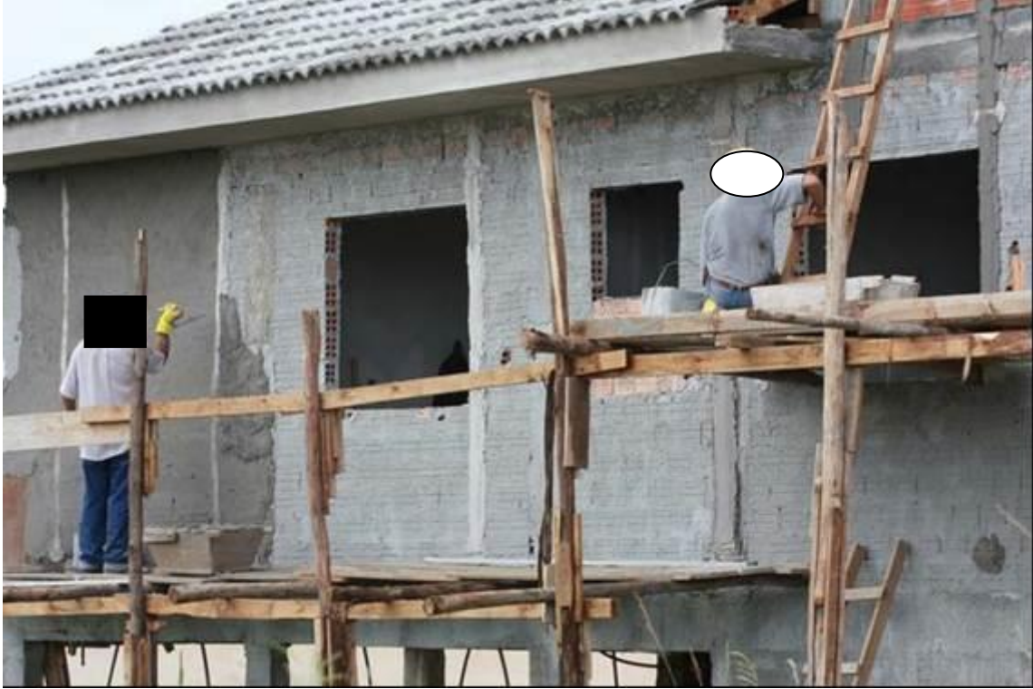
FIGURA 10 – CANTEIRO DE OBRAS 3
