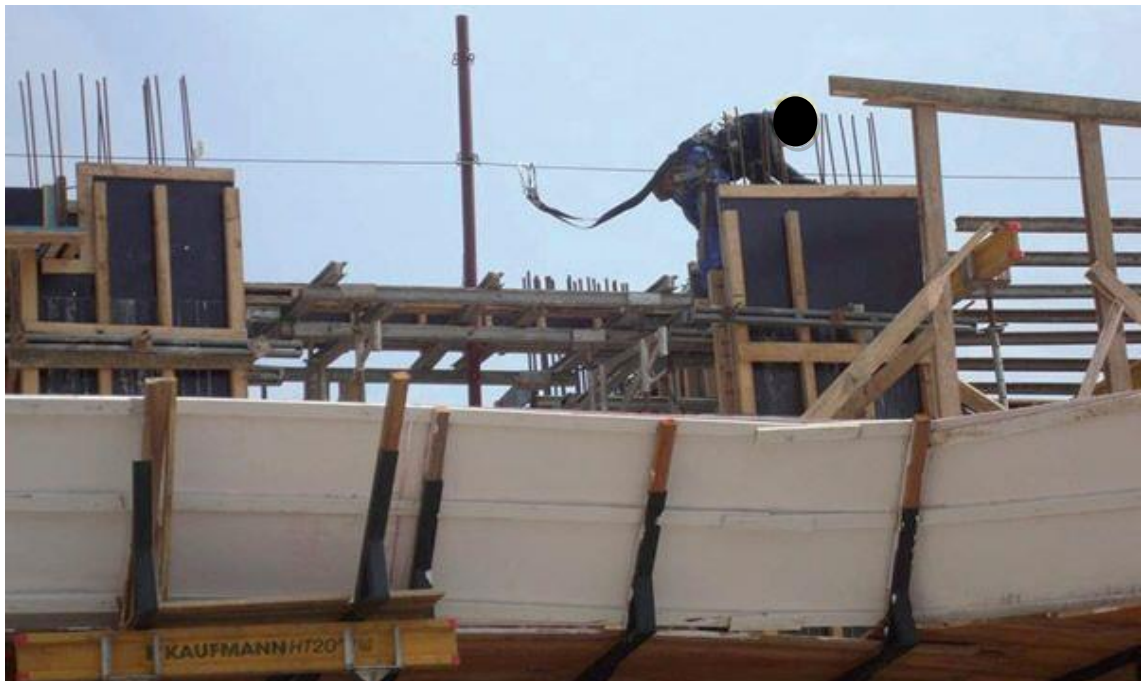
FIGURA 11 – CANTEIRO DE OBRAS 4
