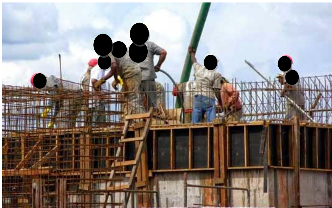
FIGURA 13 - CANTEIRO DE OBRAS 6 Fonte: O Autor (2017)
