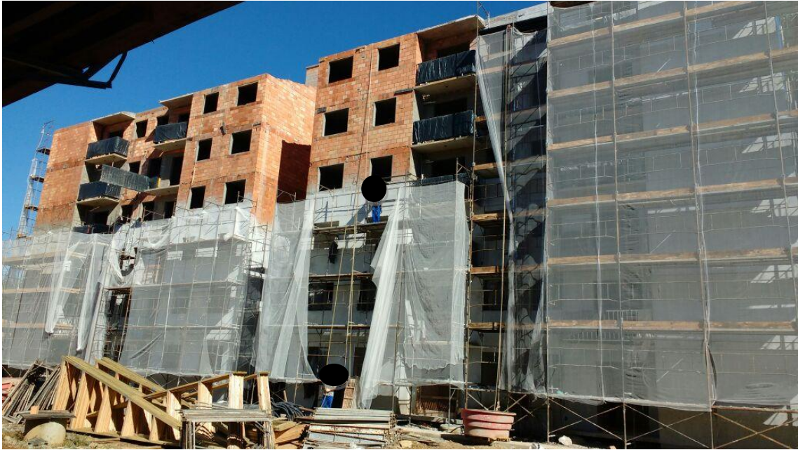
FIGURA 8 – CANTEIRO DE OBRAS 1 Fonte: O Autor (2017)
