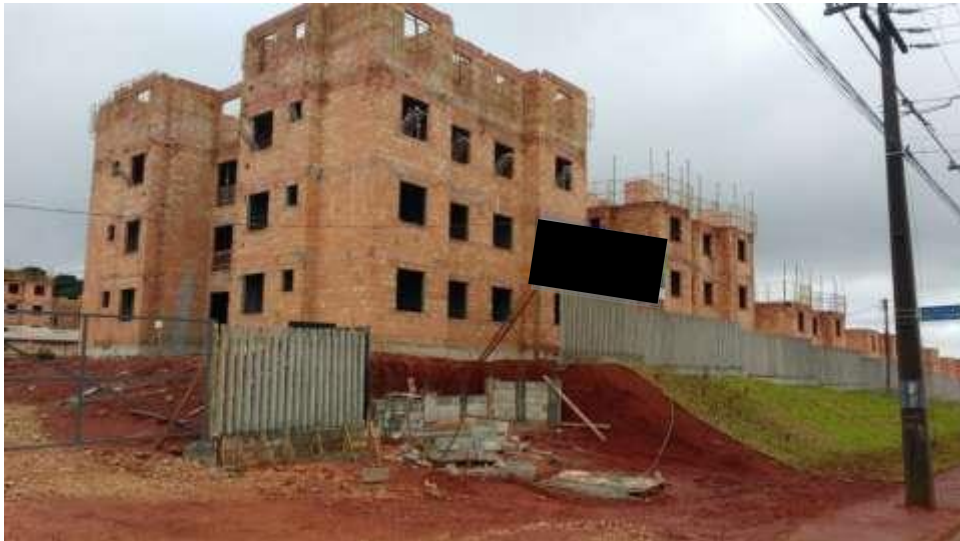
FIGURA 9 – CANTEIRO DE OBRAS 2 Fonte: O Autor (2017)
