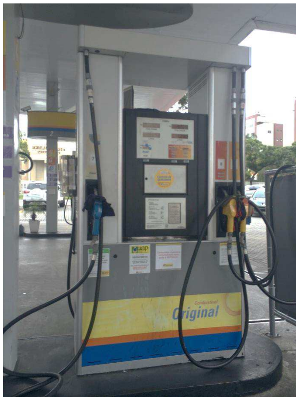
Figura 18 – Bombas de Abastecimento
