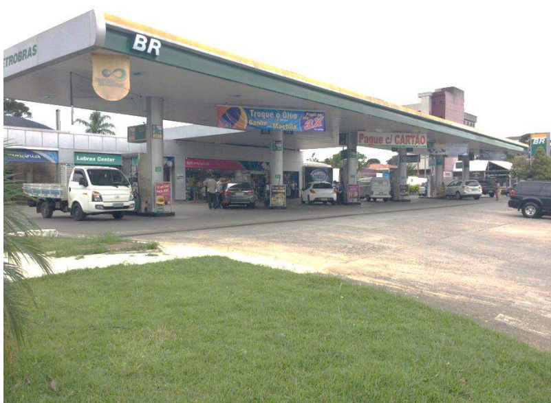
Figura 13 – Vista Geral do Posto “C”
