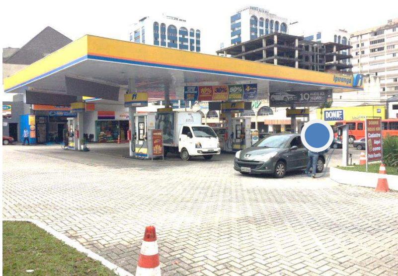
Figura 16 – Vista Geral do Posto “D”.
