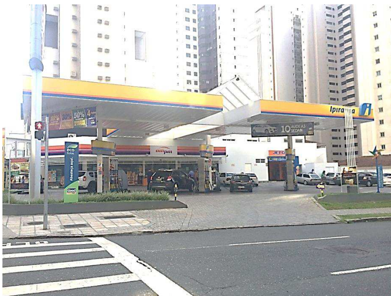
Figura 9 – Vista Geral do Posto “B”
