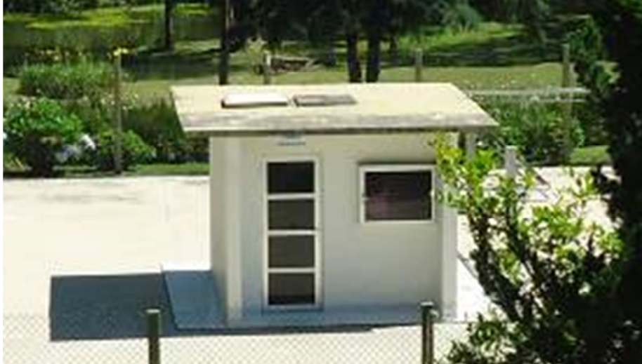
Figura 1 – Casa de Proteção da Fonte de Água Mineral em captação artificial (poço tubular profundo). Fonte: Acervo do Autor.
