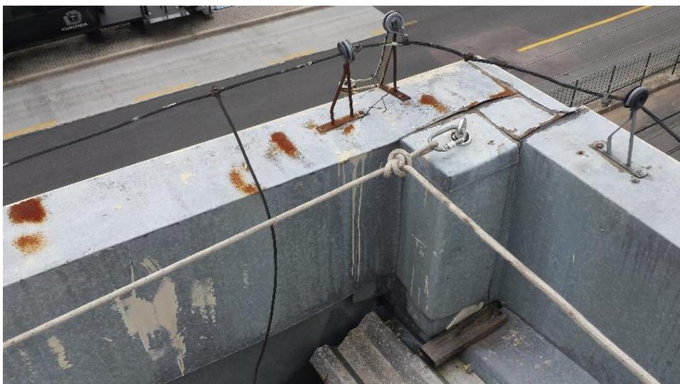
Figura 15 - Ponto de ancoragem da linha de vida provisória
